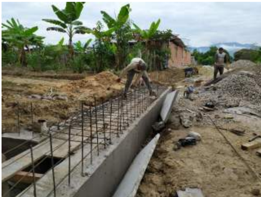
Figura 11. Proceso de armado de acero para techo de alcantarilla. Fuente: Elaboración propia.
