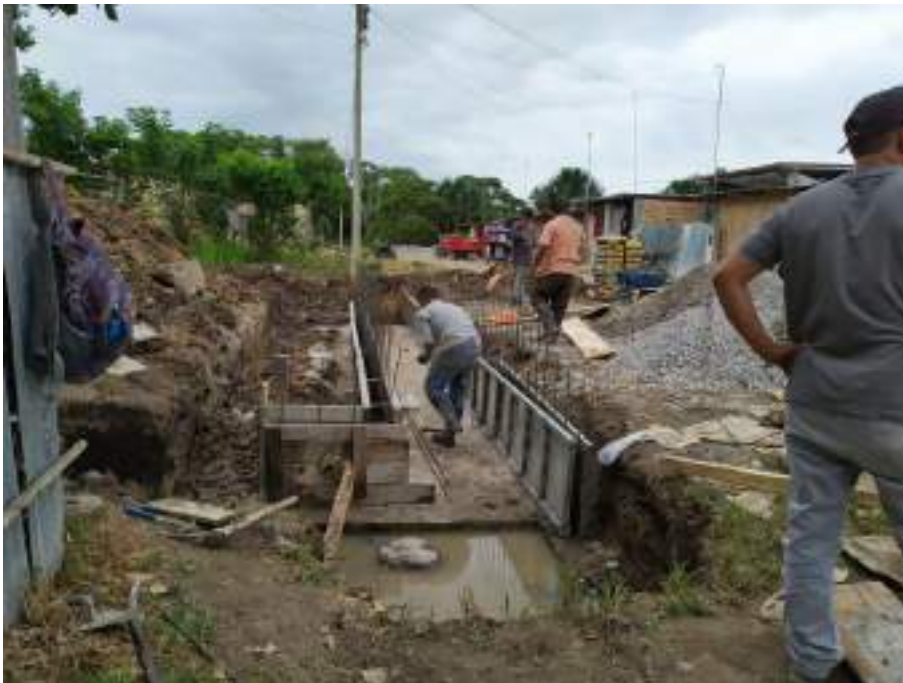
Figura 9. Proceso de encofrado para paredes de la alcantarilla. Fuente: Elaboración propia.
