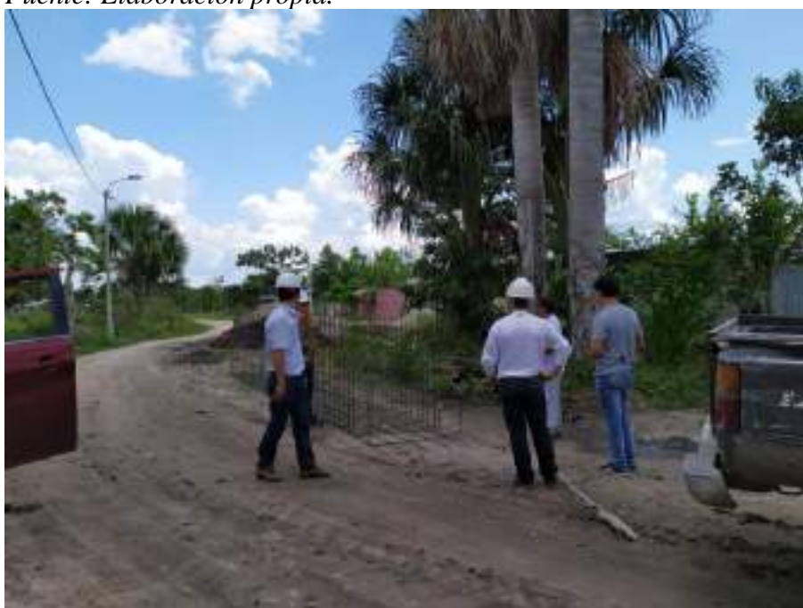
Figura 7. Proceso de armado de malla de acero de paredes y base de la alcantarilla. Fuente: Elaboración propia.
