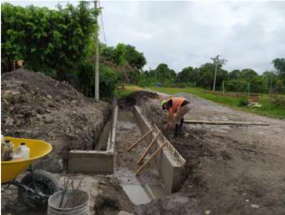
Figura 10. Proceso de desencofrado de paredes de la alcantarilla. Fuente: Elaboración propia.
