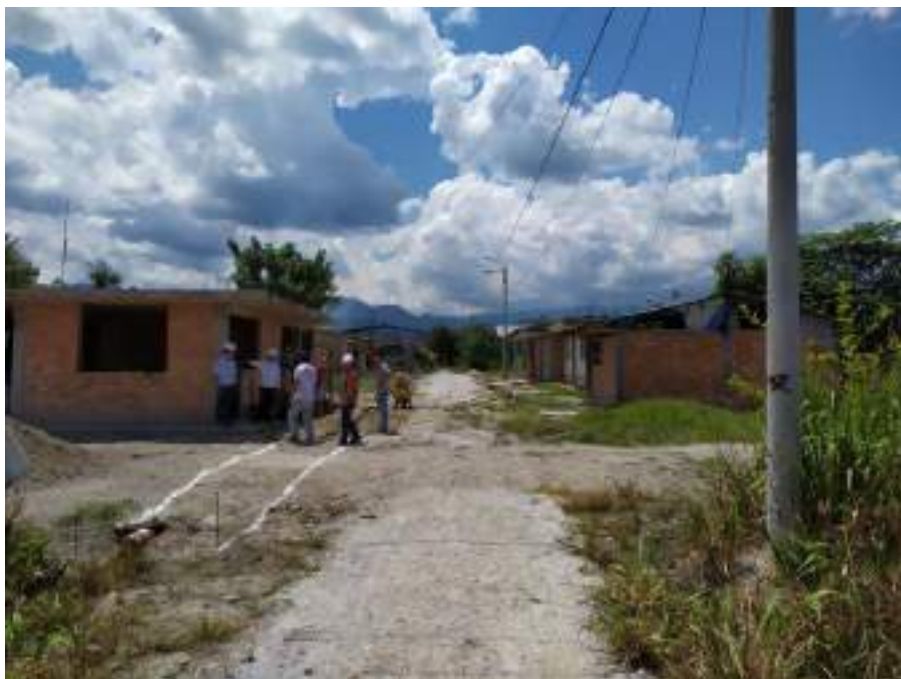
Figura 6. Proceso de Trazo, Niveles Y Replanteo. Fuente: Elaboración propia.
