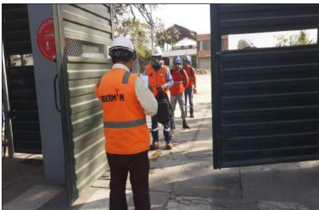
Fotografía 2. Control e inspección del correcto uso de EPPS.
