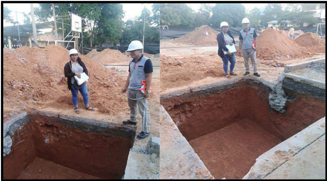
Figura 3: Excavación para la cimentación de la cobertura metálica.
