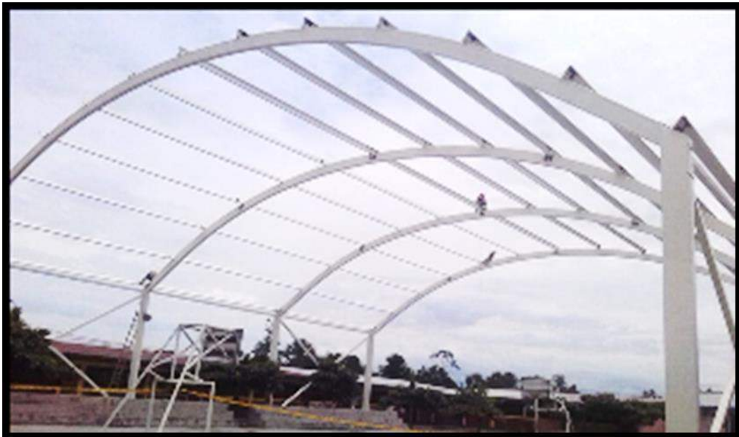
Figura 6: Estructura metálica conformada por columnas metálicas, aspas metálicas, arcos metálicos y correas, se realizó el pintado previo a la colocación de la cobertura.
