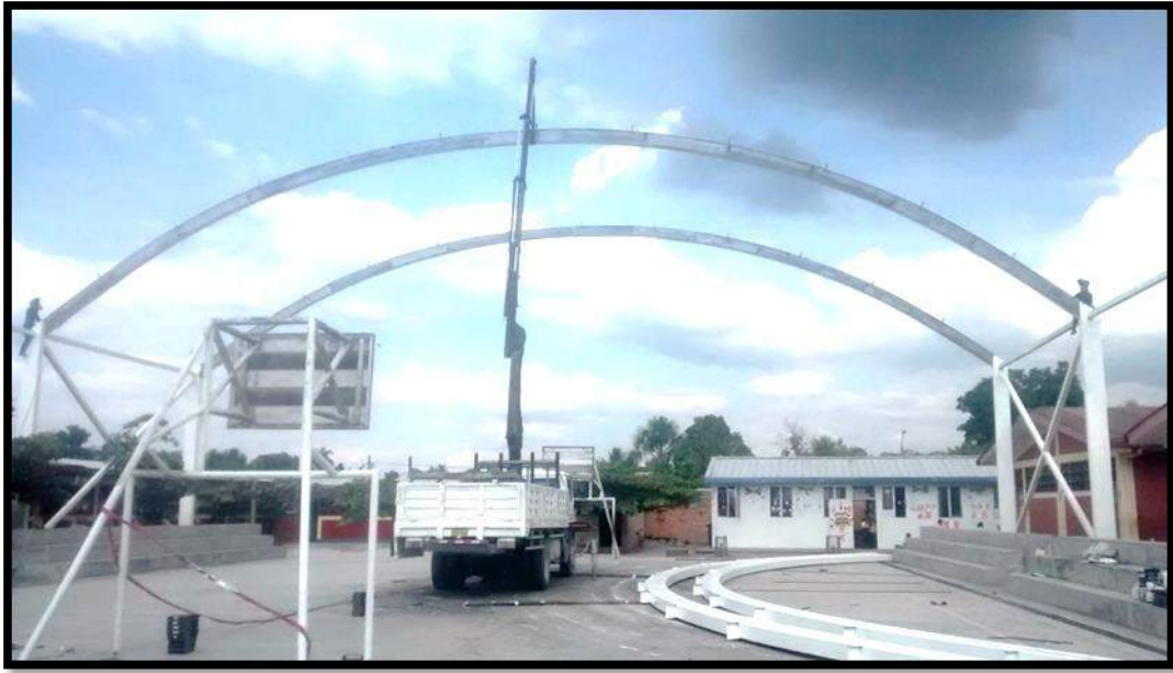
Figura 5: Instalación y montaje de arcos metálicos con maquinaria, y conectores que fijarán a las correas metálicas.
