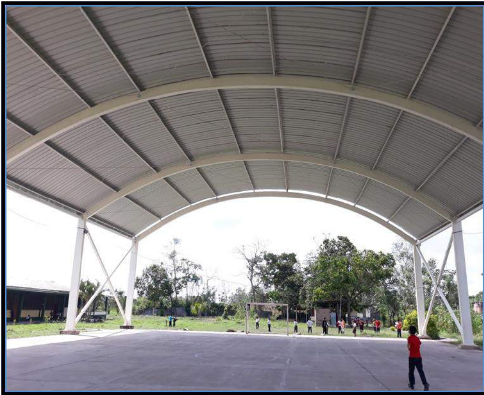
Figura 7: Vista frontal de la cobertura metálica terminada y puesta en funcionamiento.
