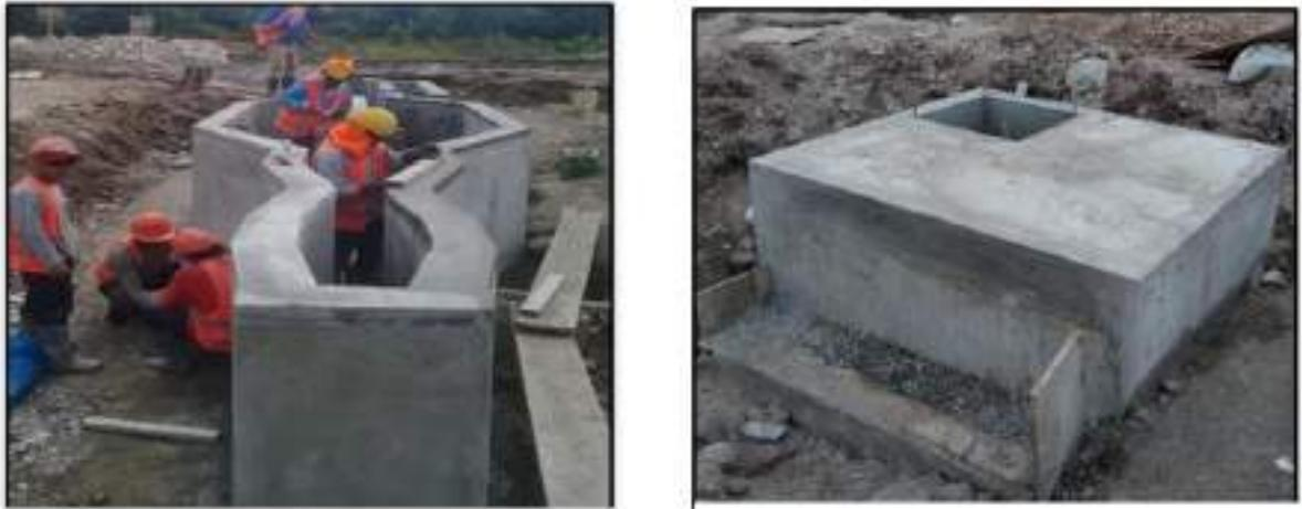
*Figura 10:* Canaleta Parahll (izquierda) y cámara repartidora de caudales (derecha).
