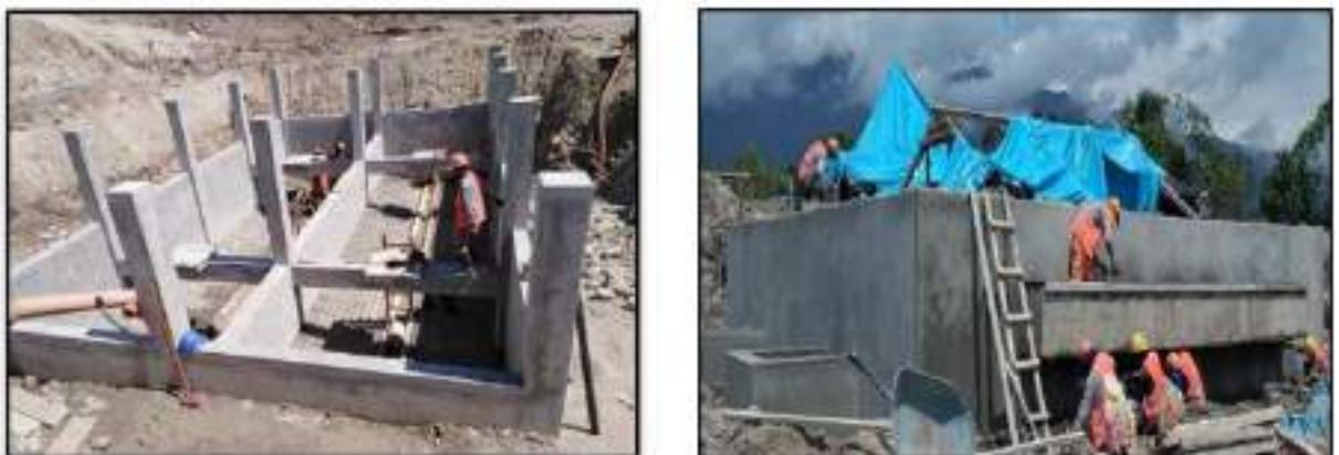
*Figura 11:* Lecho de secado (izquierda) y tanque Imhoff (derecha).
