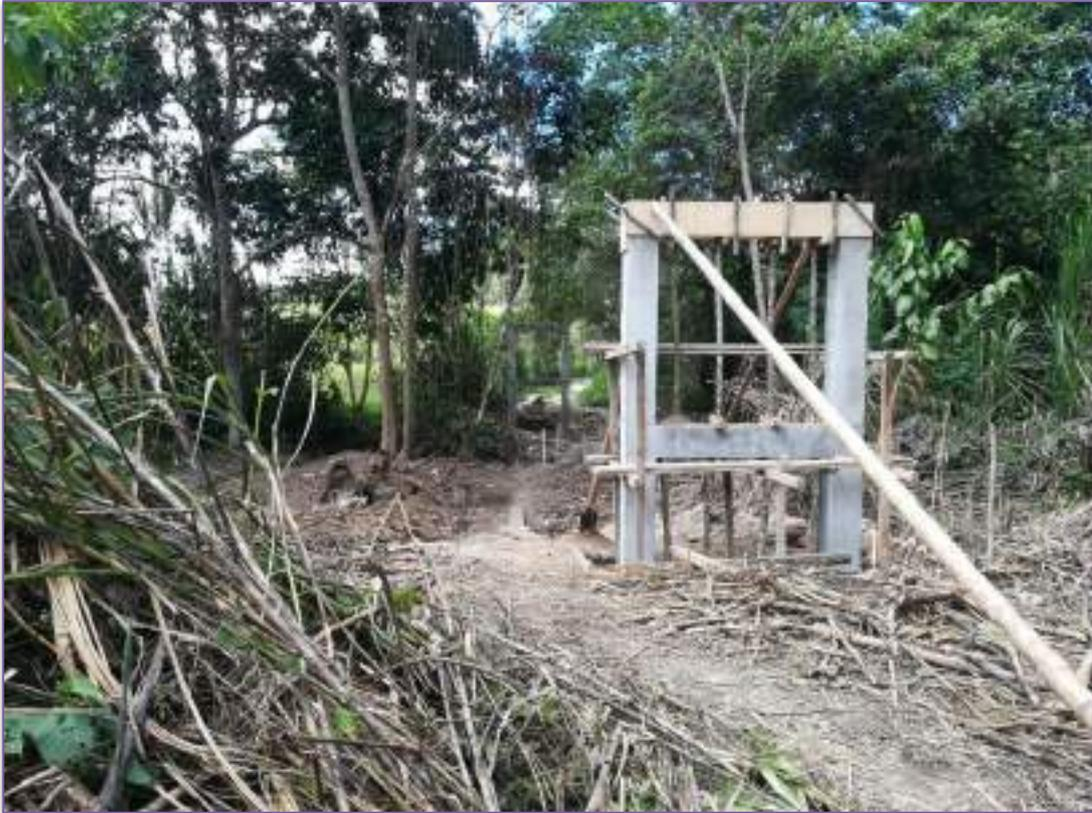
*Anexo 7. Excavación para buzones y tuberías  $\phi$  200 mm en la red de alcantarillado en la localidad de Yorongos.*
