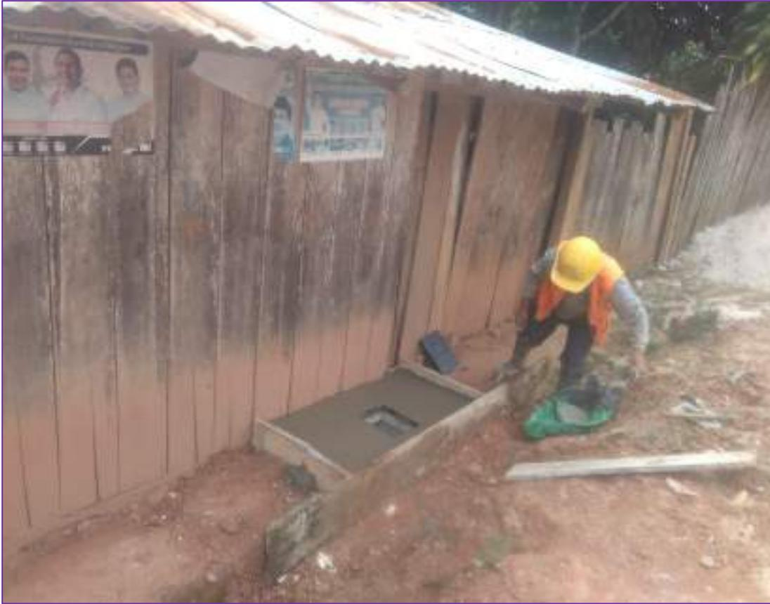
*Anexo 6. Trabajos realizados en pases aéreos en línea de conducción de la localidad de Yorongos: concreto simple y concreto armado.*
