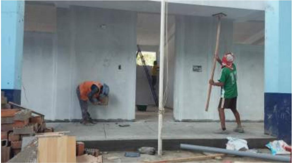
*Lijado para colocación de pintura en Muros, Vigas, Cielo rasos, Columnas*
