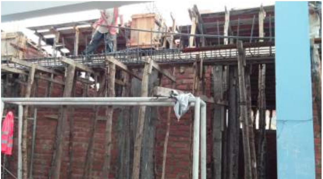
*Colocación de aceros en Viga Canal como voladizo, de la Losa Aligerada de menor dimensión*
