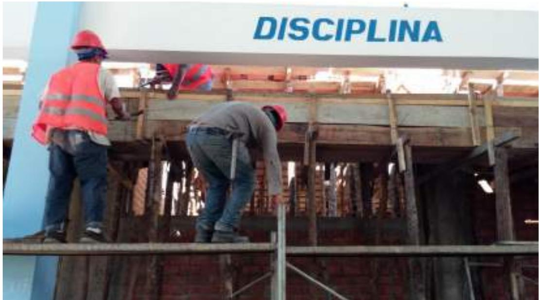
*Encofrado de Viga Canal como voladizo, de la Losa Aligerada de menor dimensión*
