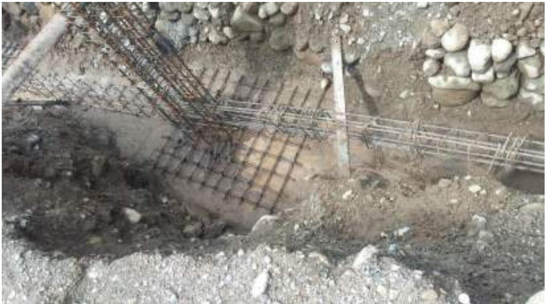
*Culminada la limpieza de aceros en el eje 1-1; a falta de redistribución de estribos, realineamiento de VC, del emparrillado de zapata y columna*
