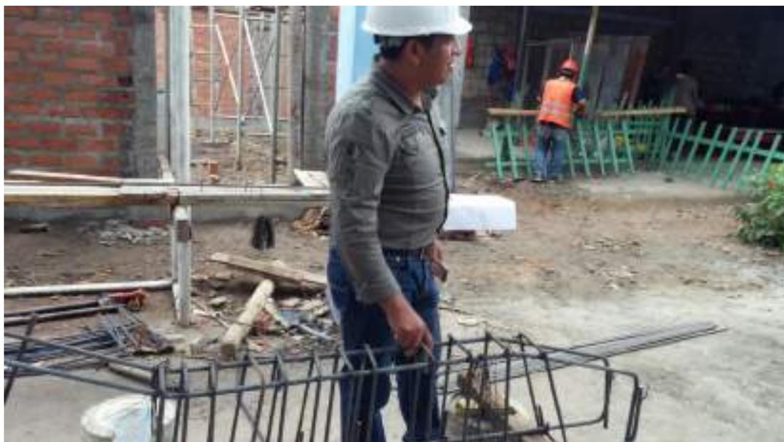
*Revisión e indicaciones del Ingeniero Residente para el armado de la viga en voladizo del eje 3-3*
