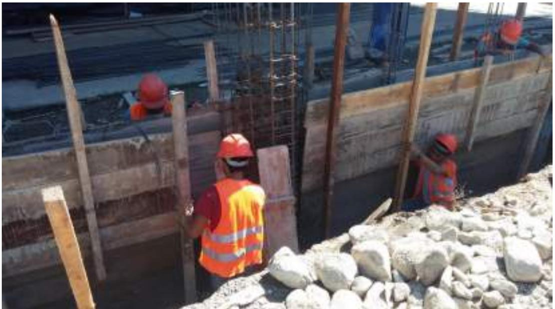
*Encofrado para vaciado de sobrecimiento a 1.5m del eje 3-3-*
