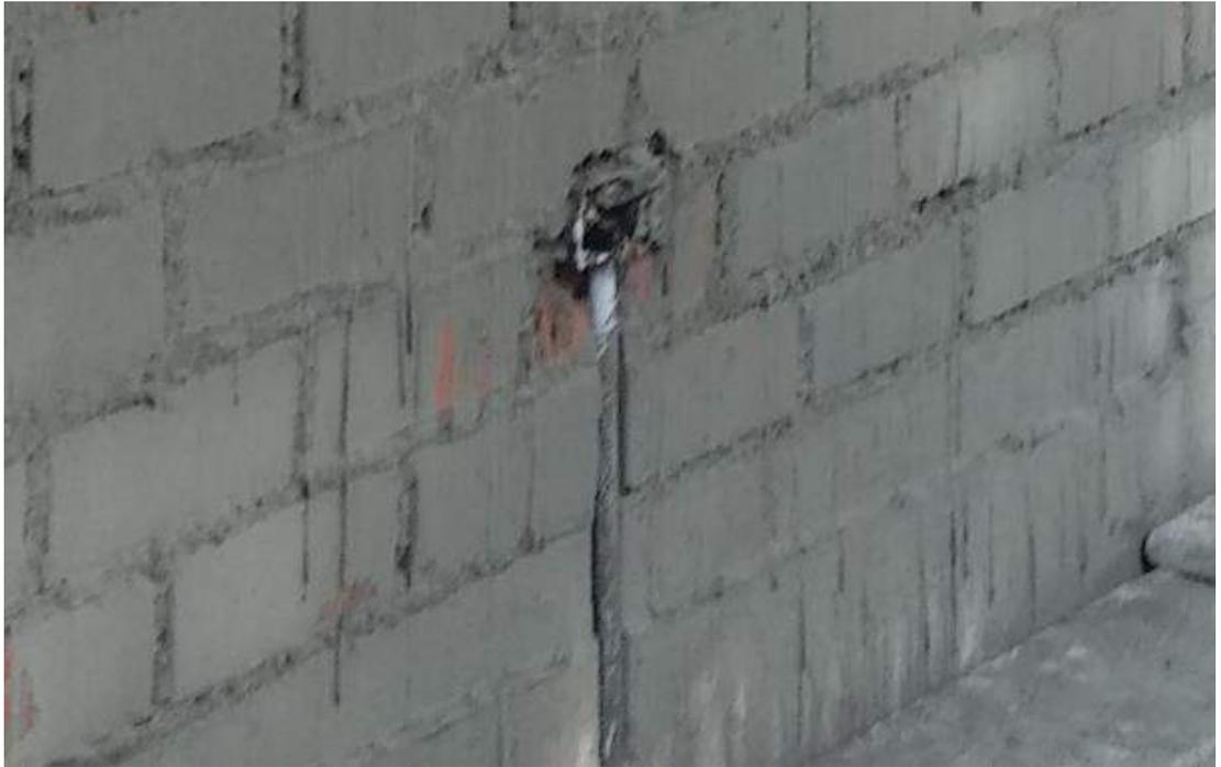
*Colocación de tubería para tomacorrientes*
