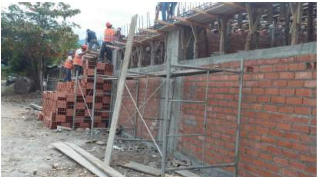
*Colocación de Ladrillos de Losa Aligerada*
