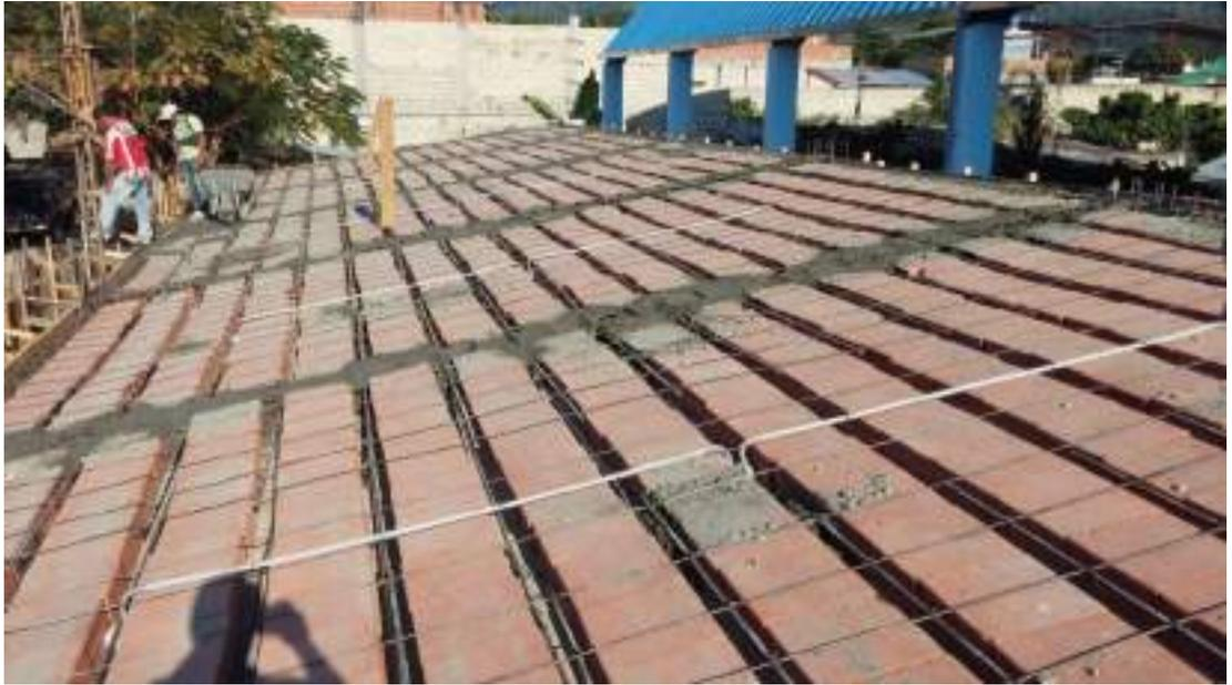
*Colocación de tubería para luminarias e interruptores, comienzo de vaciado en vigas peraltadas.*
