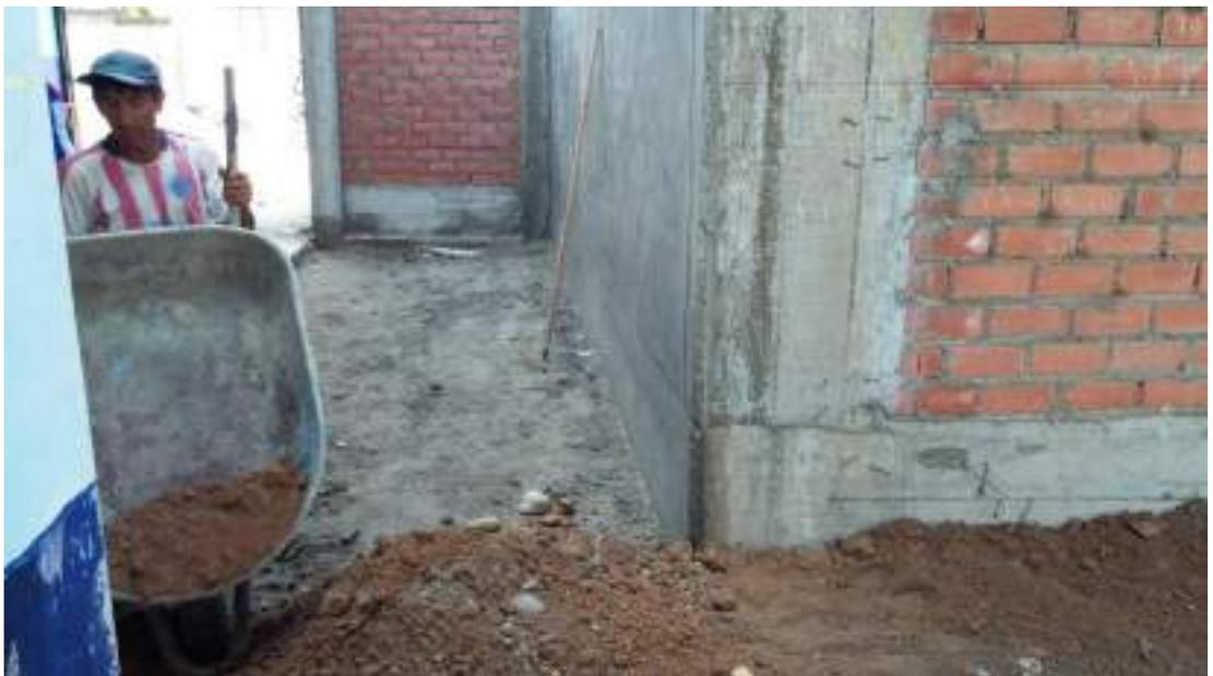
*Relleno con material Ripeo en un lado (eje A-A) de la construcción*
