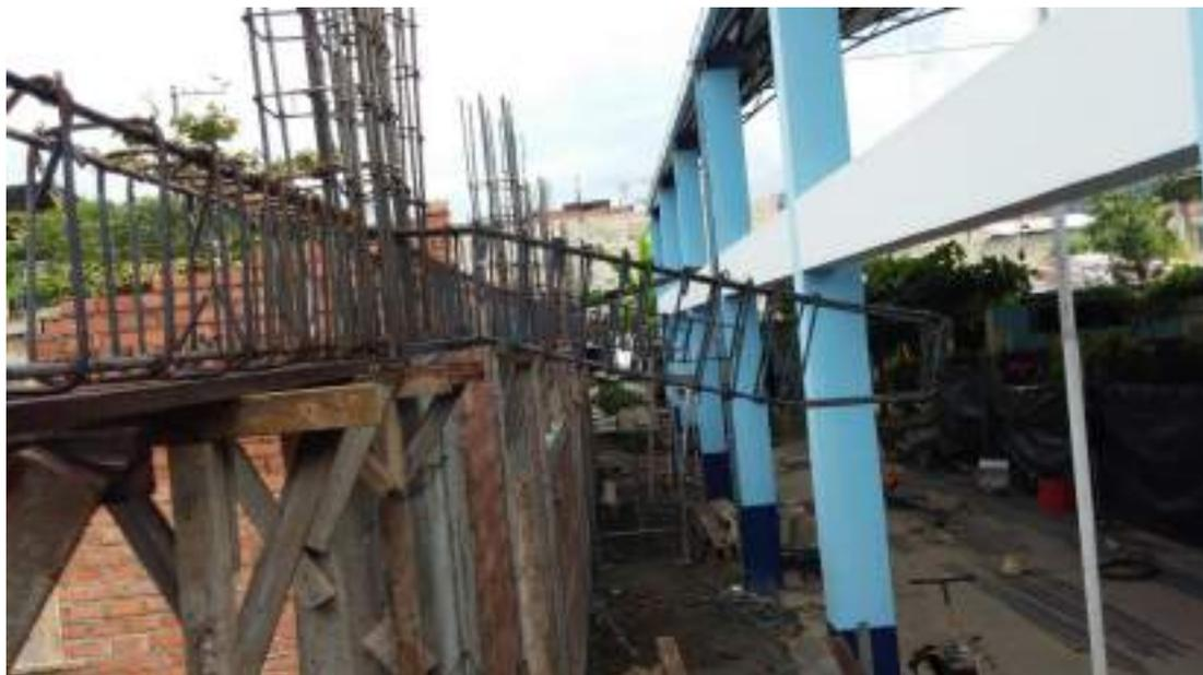
*Colocación de Vigas para losa en voladizo*
