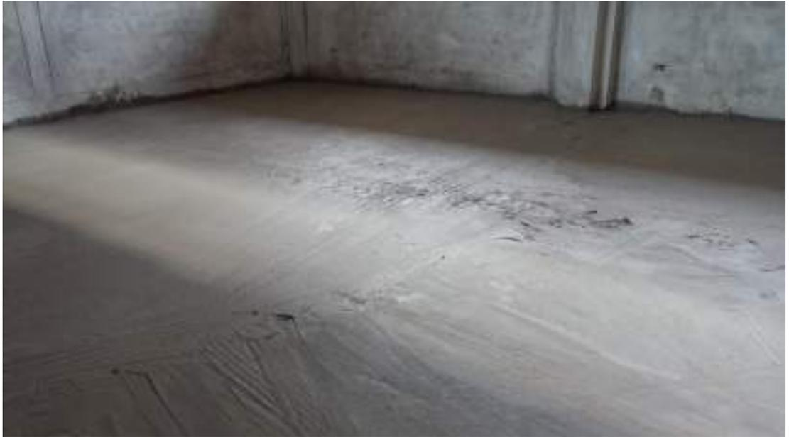
*Culminación de vaciado de Falso Piso en aula, a falta del frotachado final*
