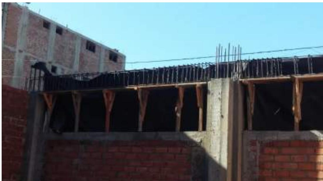
*Tejido de armadura en la viga del eje 1-1*
