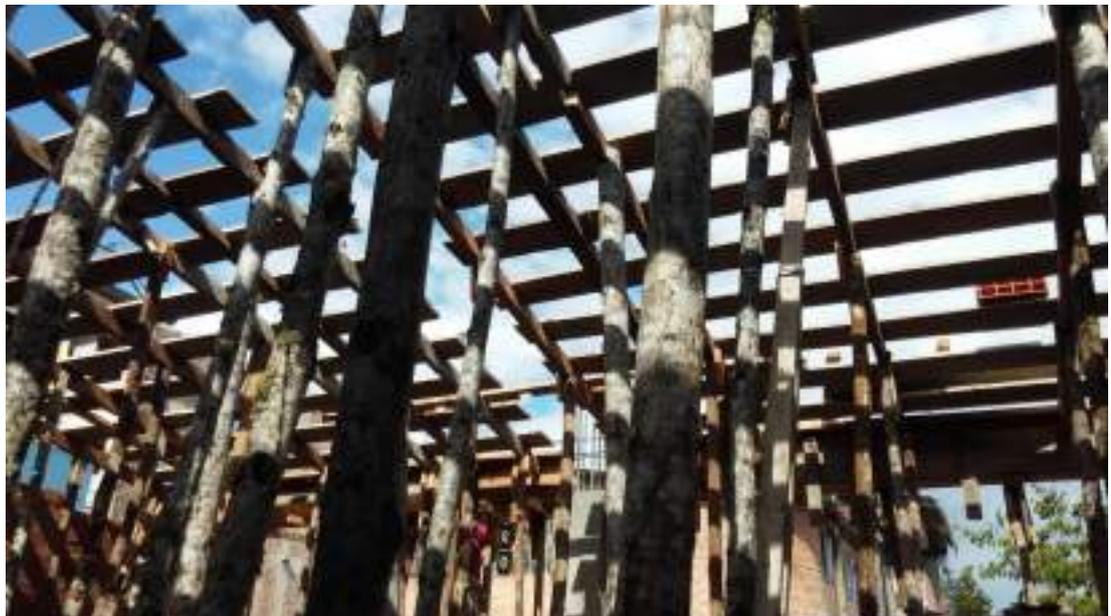
*Colocación de pies derechos y entablado de encofrado para Losa Aligerada*
