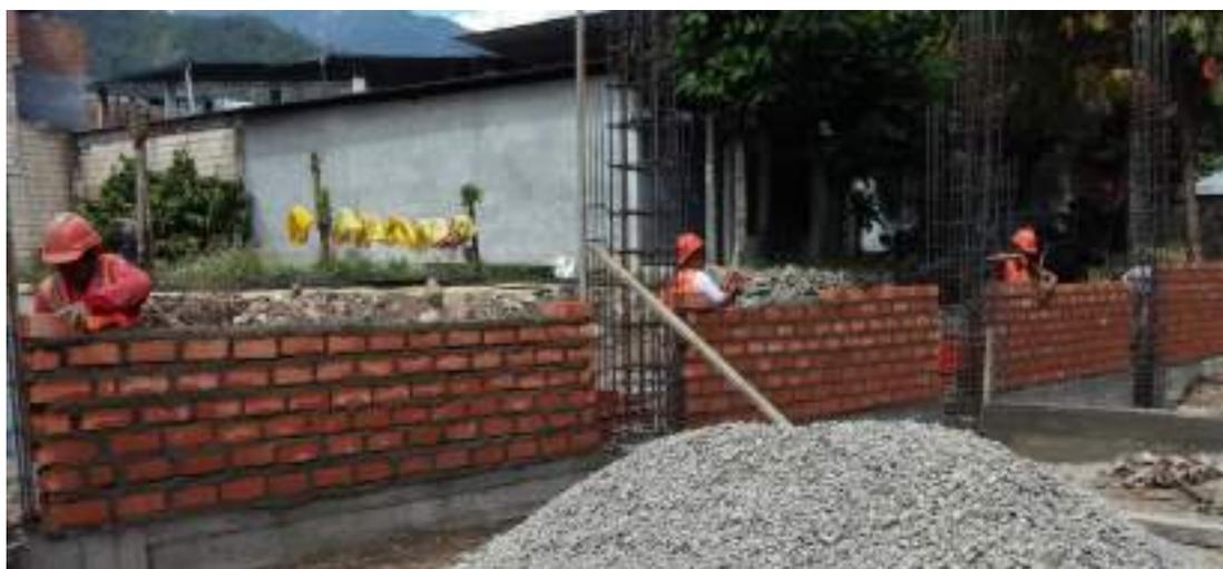
*Desenfofrado del sobrecimiento en los ejes A-A, C-C, E-E y G-G. Además de asentado de ladrillo debidamente alineado*
