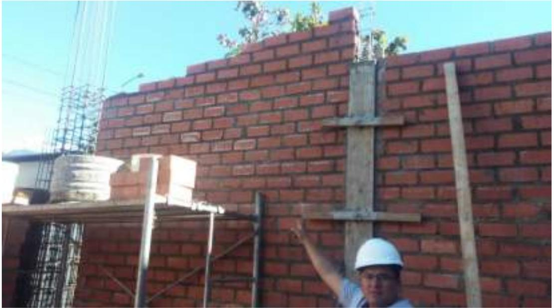
*Indicación del Ingeniero Supervisor sobre el encofrado de columnetas de albañilería confinada*
