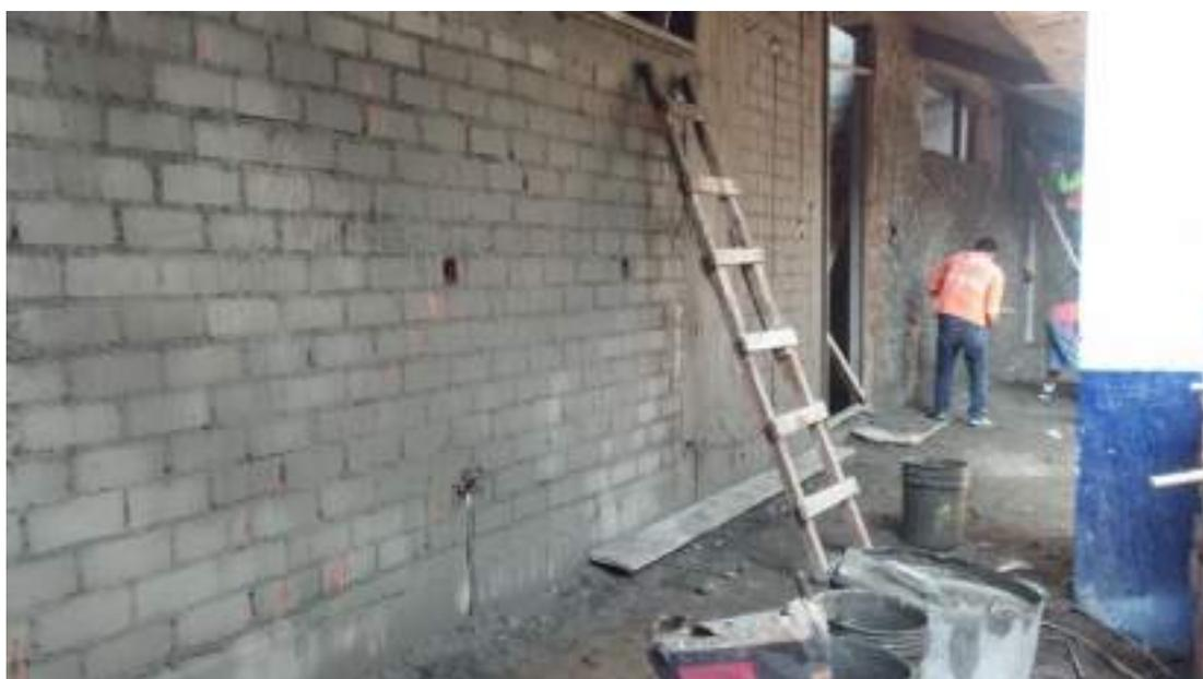
*Tarrajeo de Muro en frontis (eje 3-3); e inclusión de cajas rectangulares para tomacorrientes e interruptor*
