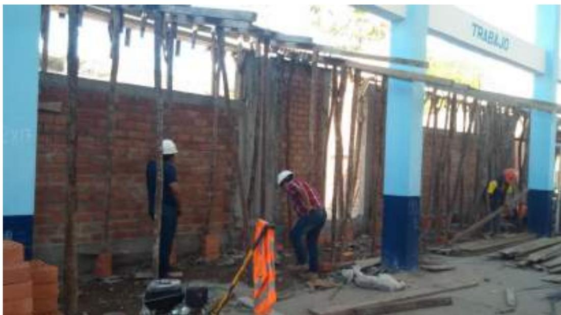
*Revisión e indicaciones del Ingeniero Residente y Supervisor para el armado del encofrado de losa en voladizo (revisión de pies derechos)*
