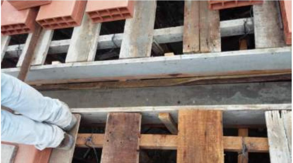
*Encajonado de Vigas Peraltadas, en la Losa Aligerada de mayor dimensión*
