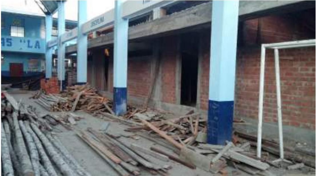
*Desencofrado de Losa Aligerada en Voladizo, de Losa Aligerada de mayor dimensión, de Vigas Canal*
