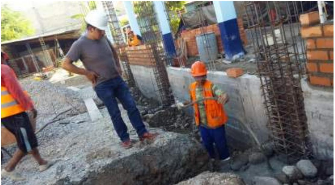
*Indicaciones del Ingeniero Residente para el vibrado del vaciado de la VC de los ejes A-A, B-B, C-C, D-D, E-E, F-F, G-G*
