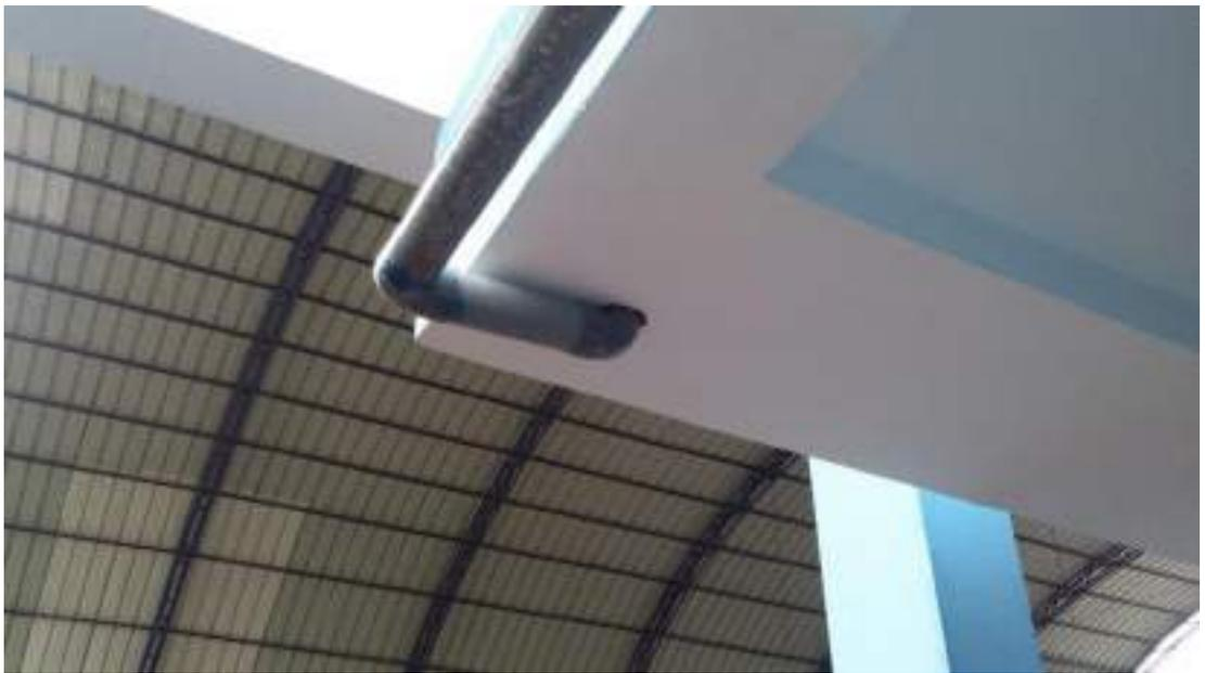
*Colocación de tubería de desagüe Pluvial*
