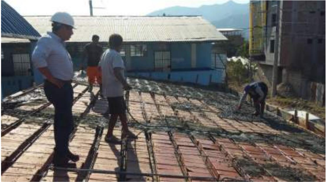
*Revisión de la colocación de tuberías del sistema eléctrico y del vaciado*
