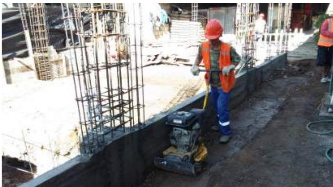
*Relleno y compactación por capas con compactadora tipo plancha en el eje 3-3*
