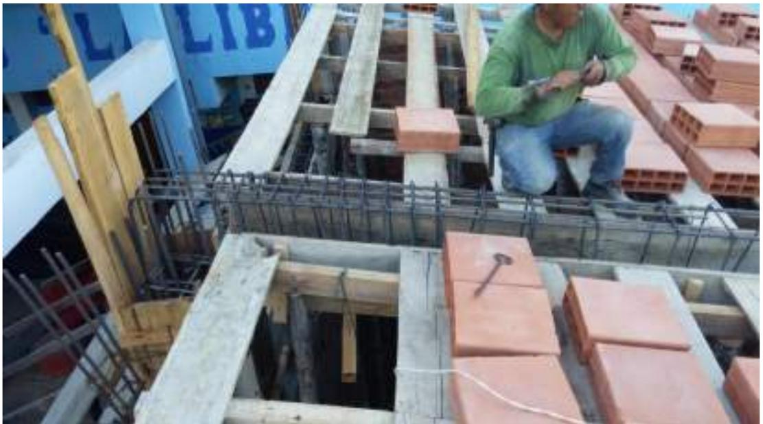
*Colocación de 2 bastones en la armadura de la Viga Peraltada*
