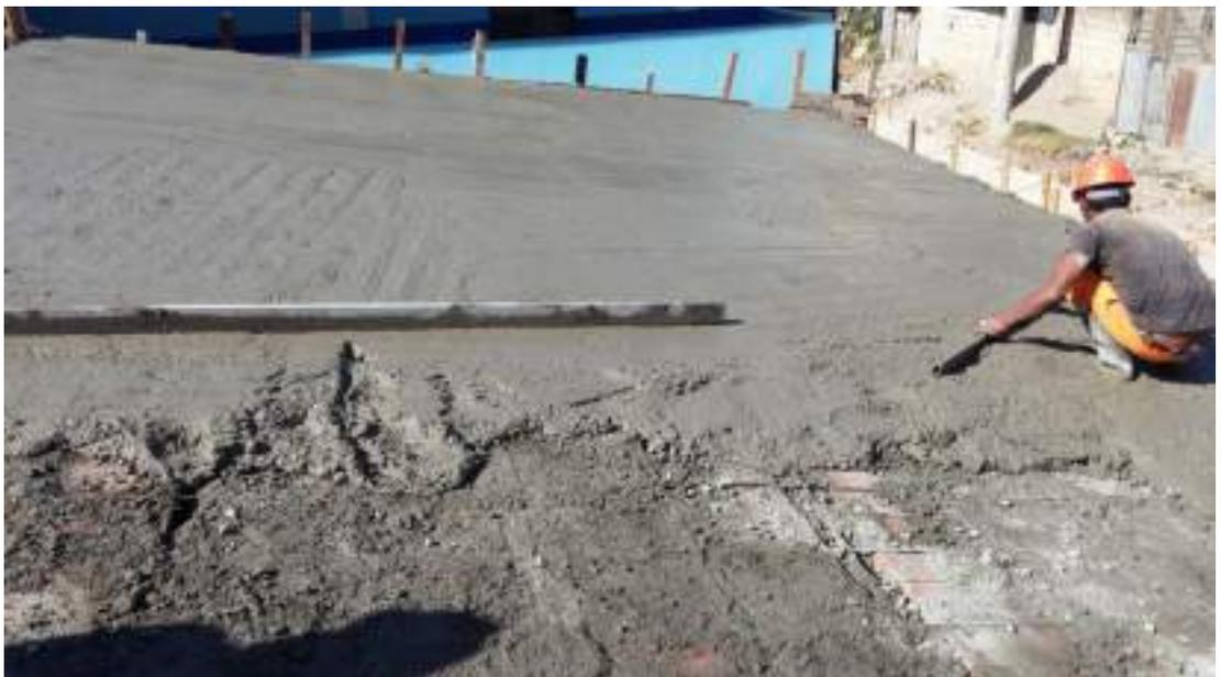
*Reglado del vaciado de la Losa Aligerada*
