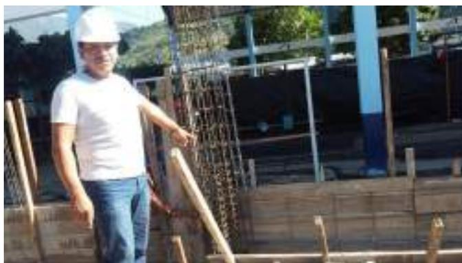
Figura 29 Armado de encofrado de Sobrecimiento Armado
