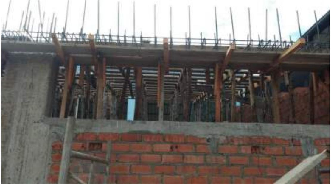
*Colocación de Acero en Viga Canal y Encofrado de Viga del eje 1-1*
