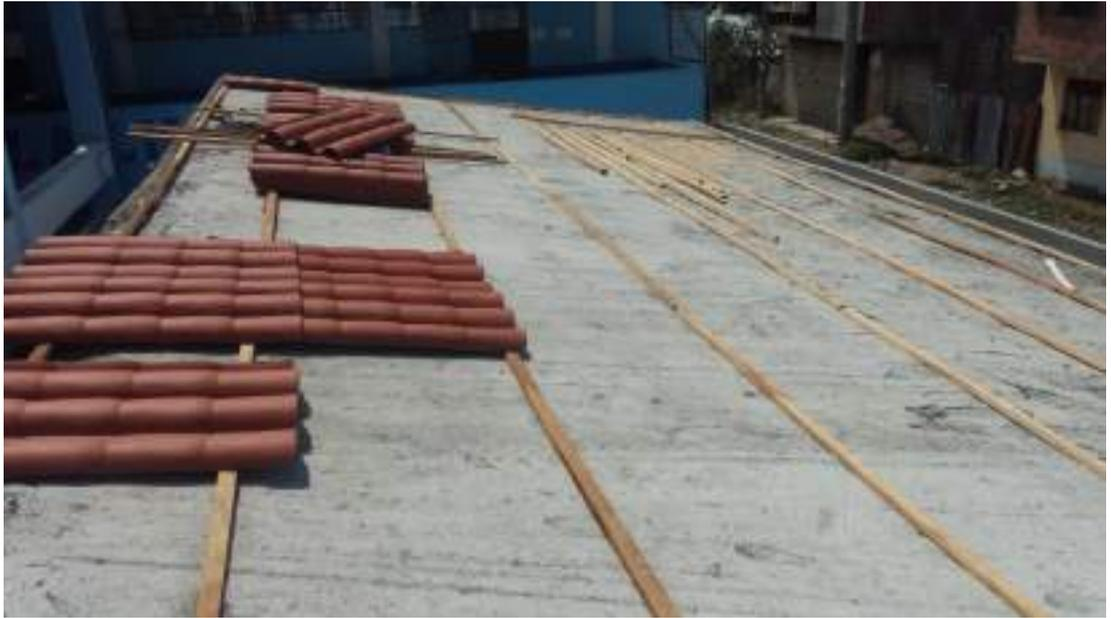
*Nivelación y colocación de listones de madera para colocación de teja andina*
