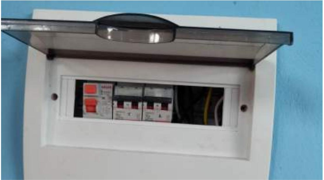
*instalación de Cuchillas en Tablero de Distribución*
