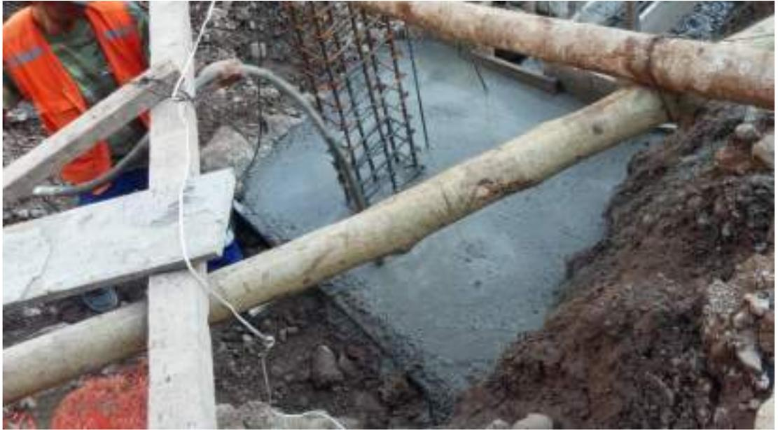
*Vaciado y vibrado de Zapata y VC para su vaciado del eje 1-1*
