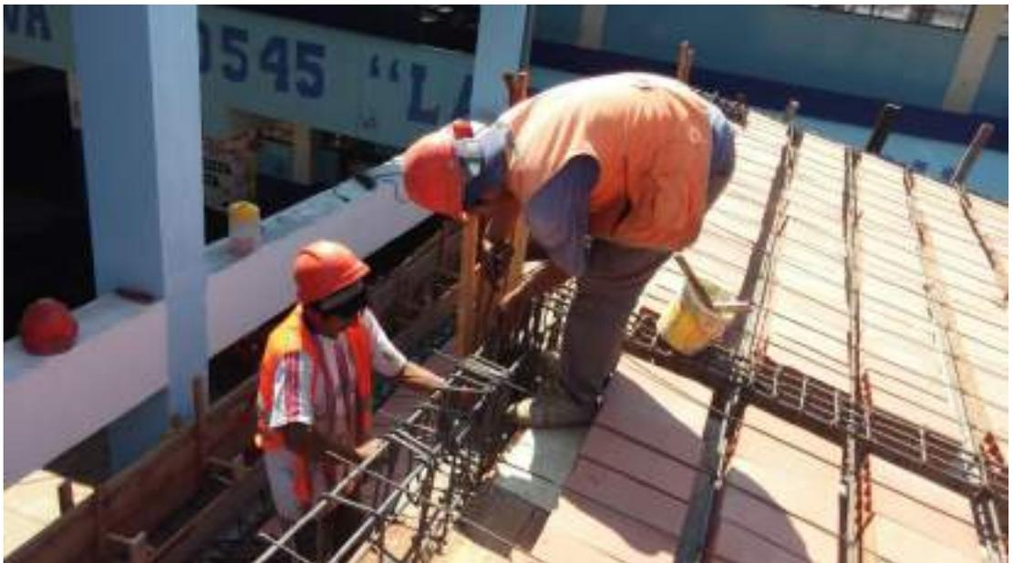
*Colocación de acero de Temperatura en Losa Aligerada de mayor dimensión*
