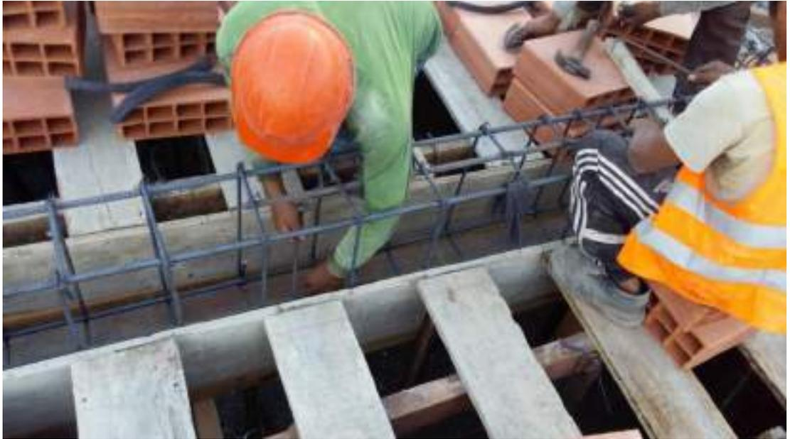
*Colocación de balancín en la Viga Peralta*
