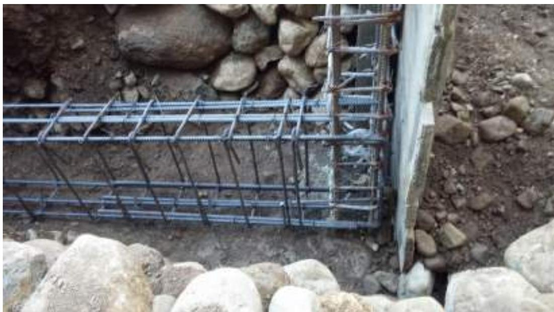
*Acero en VC y encofrado del eje A-A*
