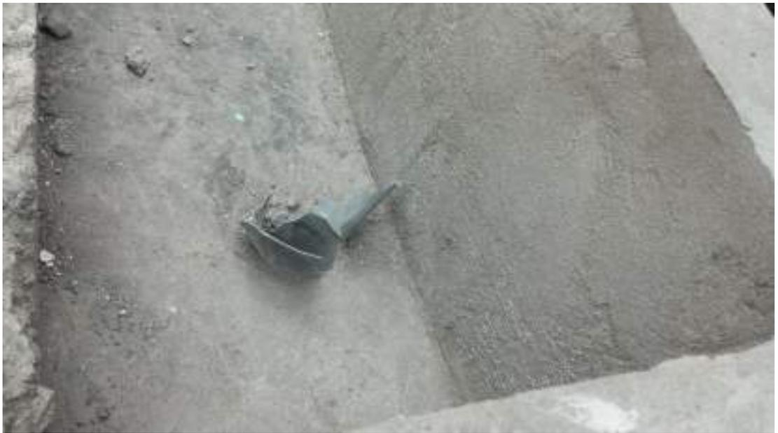
*Tarrajeo interno de viga canal (con impermeabilizante)*
