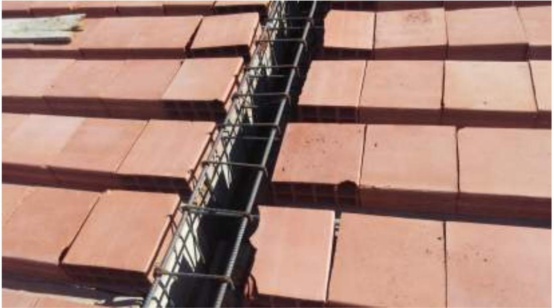
*Colocación de ladrillos en la Losa Aligerada de mayor dimensión, dejándolos listos para el mojado y vaciado.*
