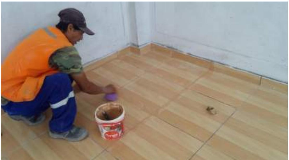
*Colocación de fragua en juntas de las losetas*
