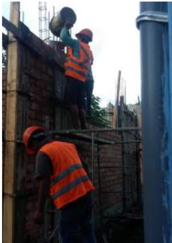
*Vaciado de columnas y columnetas de albañilería confinada*
