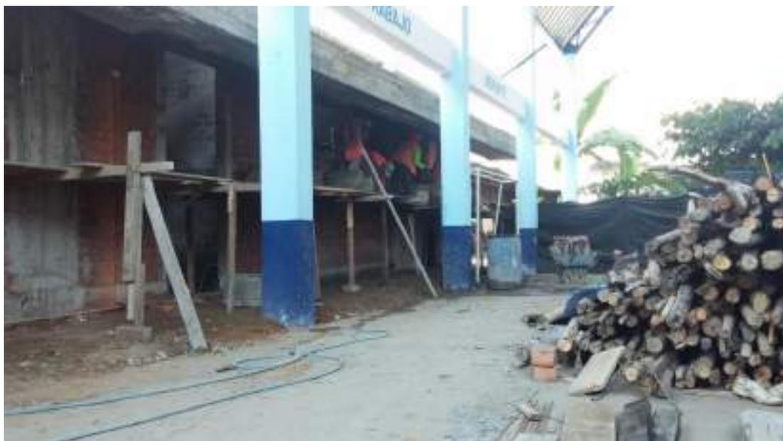
*Tarrajeo en cielo raso, y viga en losa aligerada pequeña (eje 3-3) en voladizo*
