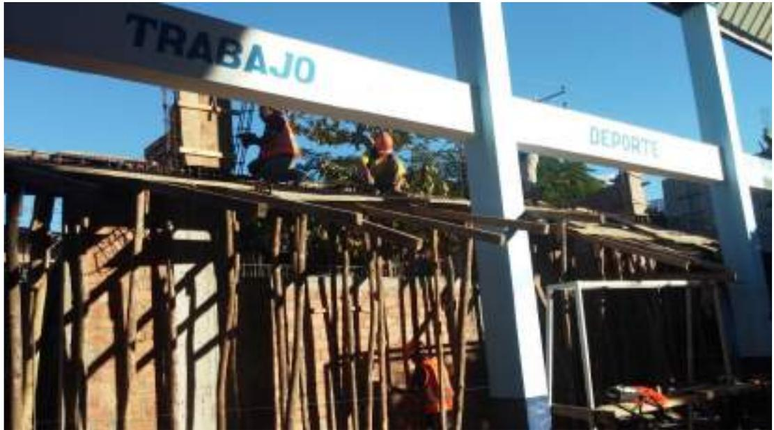
*Elaboración de cajones para la columnas, y se dejan de lado las columnetas, puesto que se analiza la vialidad de apertura como ventana en la parte superior*
