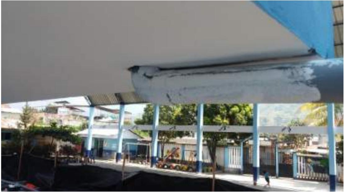
*Colocación de tubería de desagüe Pluvial*
