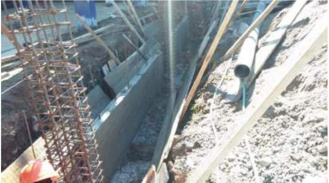
*Desencofrado del vaciado de concreto de sobrecimiento a 0.90m del eje 3-3*
