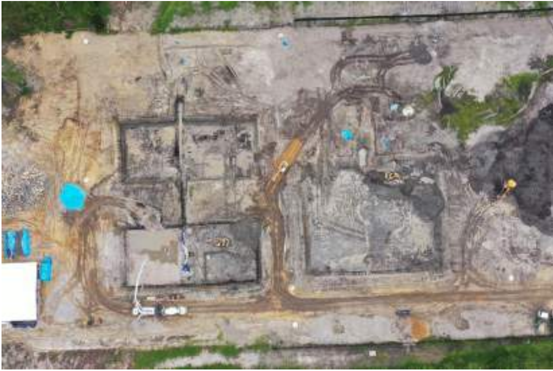
Figura 23: Ensanchamiento de vías de acceso en PTAR.
