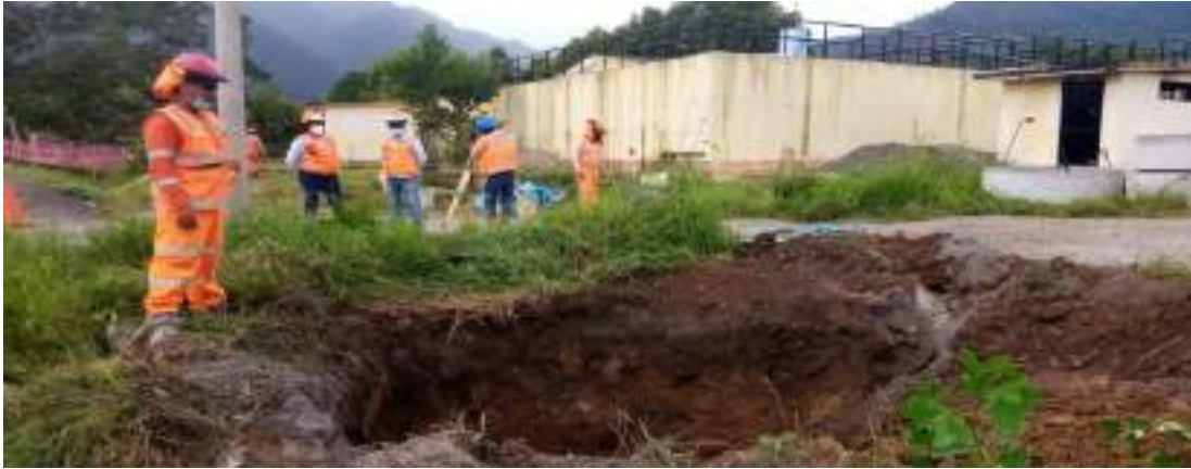
Figura 25: Línea de drenaje interno PTAP.
