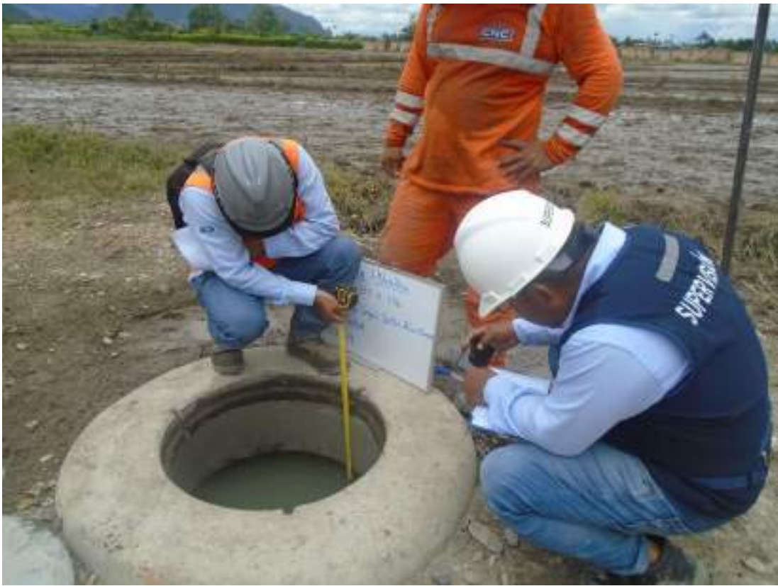
Figura 18: Prueba hidráulica a zanja tapada.
