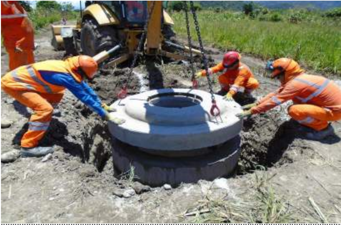
Figura 15: Instalación de buzones pre fabricados.
