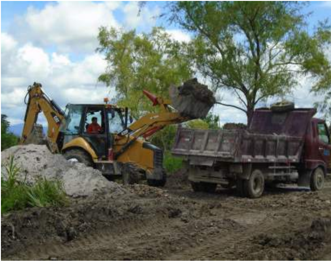
Figura 20: Eliminación de material excedente.
