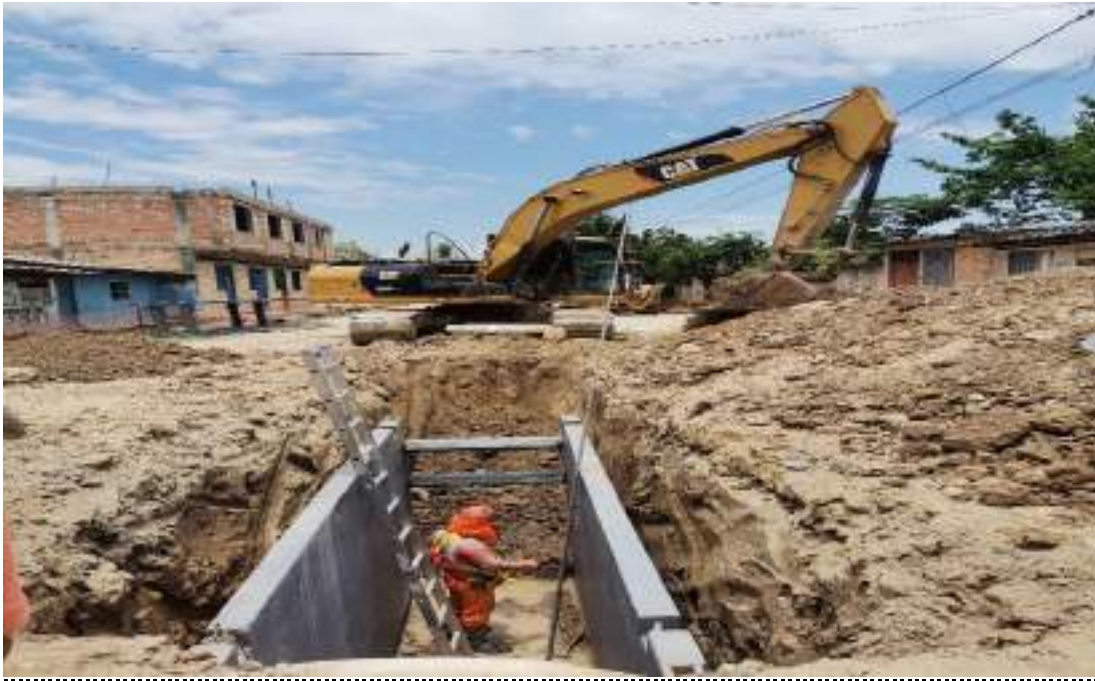
Figura 19: Uso de entibados metálicos para colectores y tramos profundos.
