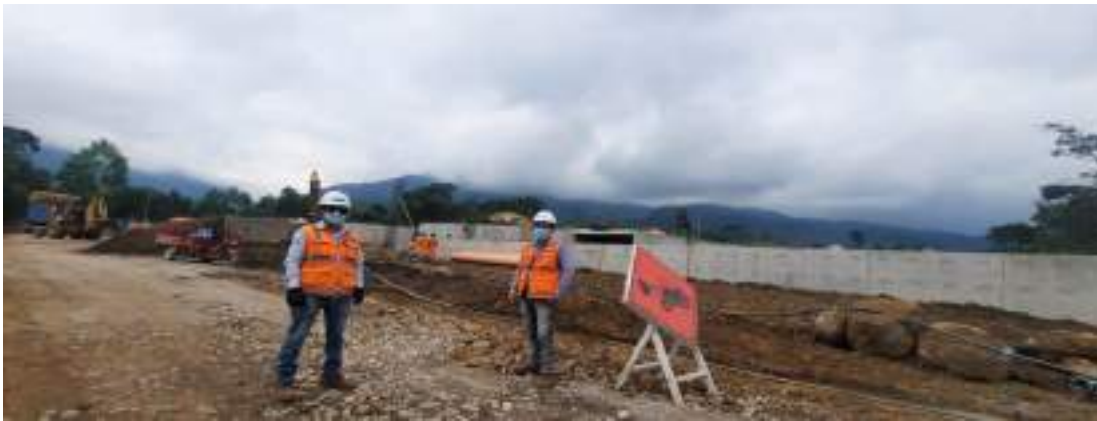
Figura 26: Línea de drenaje externo PTAP.
