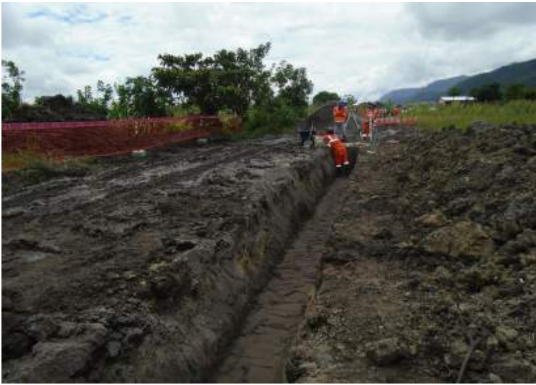
Figura 16: Línea de alcantarillado y habilitación de accesos.
