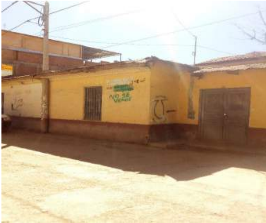
Figura 60. Inspección de vivienda informal - Jr. Pasco
