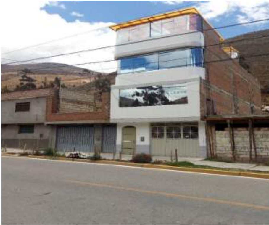
Figura 58. Inspección de vivienda informal - Av. Pacheco
