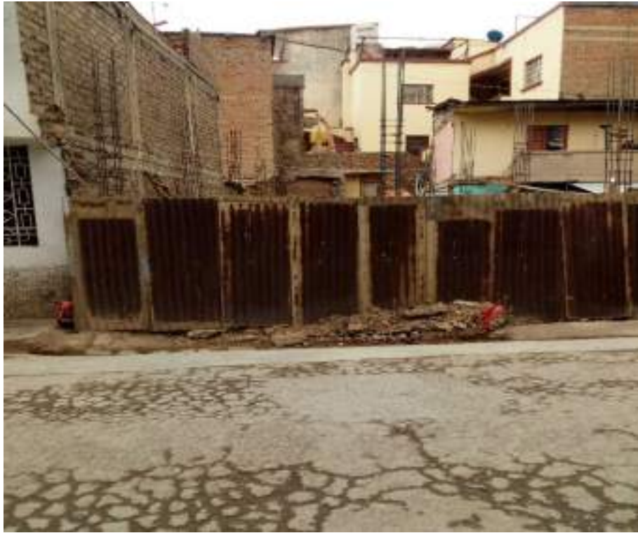
Figura 56. Inspección de construcción informal - Jr. Francisco Mendizabal
