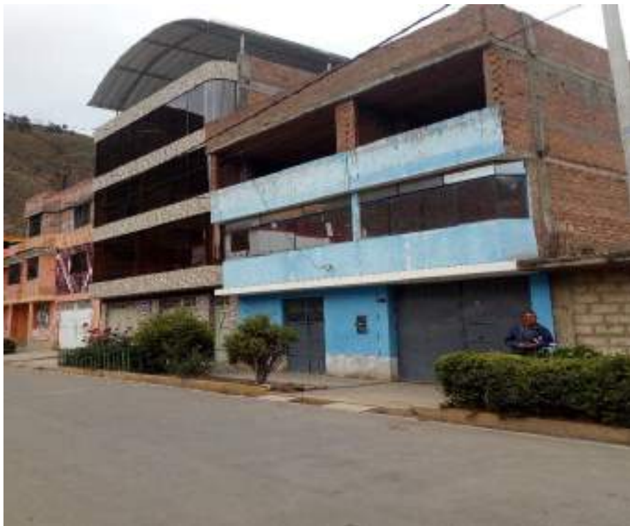
Figura 59. Inspección de vivienda informal - Jr. Los Cipreses
