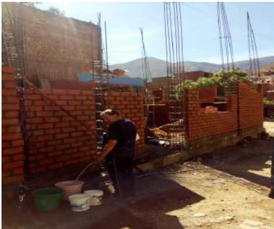
Figura 61. Inspección de vivienda informal - Av. Pacheco
