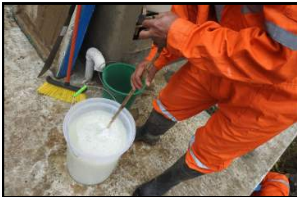
Figura 21. Disolviendo la solución de cloro Fuente: Elaboración propia
