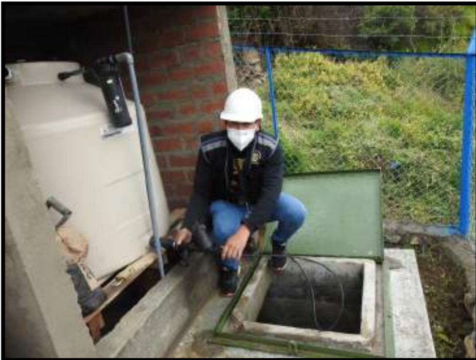
Figura 28. Instalación del sistema de cloración por goteo Fuente: Elaboración propia
