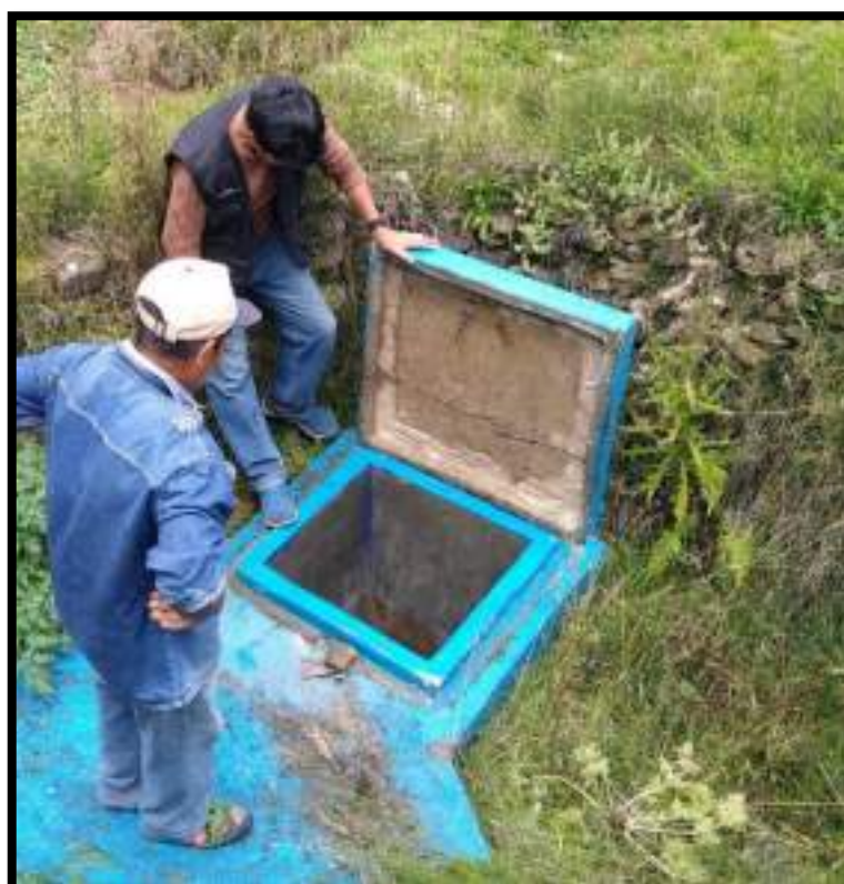
Figura 17. Estado de la captación
