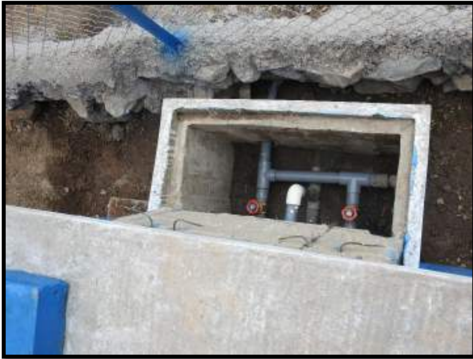
Figura 27. Mejoramiento de la caja de válvulas. Fuente: Elaboración propia
