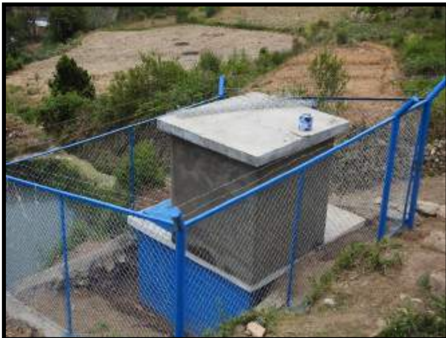
Figura 26. Se construyó la caseta de cloración Fuente: Elaboración propia
