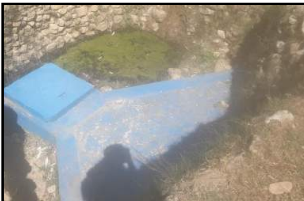
Figura 16. Estado de la Captación
