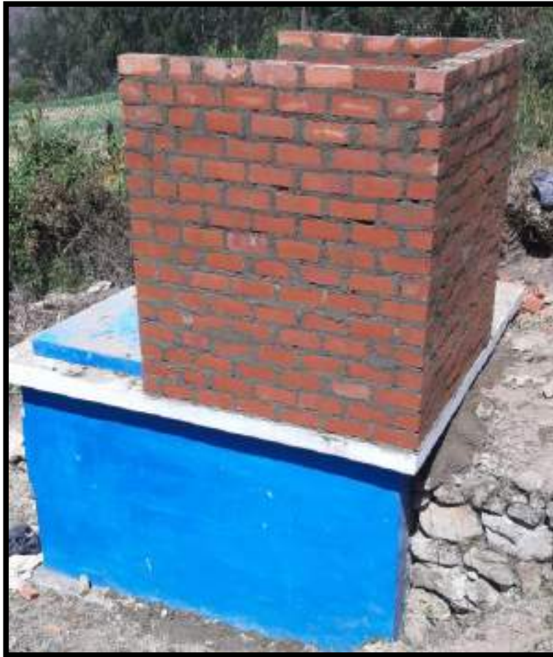
Figura 10. Proceso Constructivo de la Caseta de Cloración Fuente: Elaboración propia
