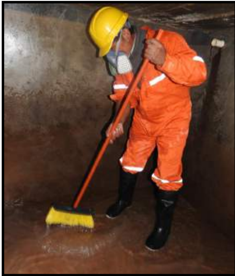
Figura 22. Limpieza al interior del reservorio Fuente: Elaboración propia
