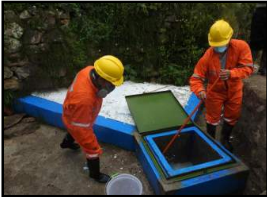
Figura 29. Se realiza la limpieza de desinfección de la captación Fuente: Elaboración propia
