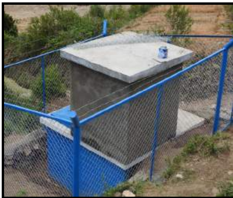
Figura 12. Construcción de la caseta de cloración Fuente: Elaboración propia
