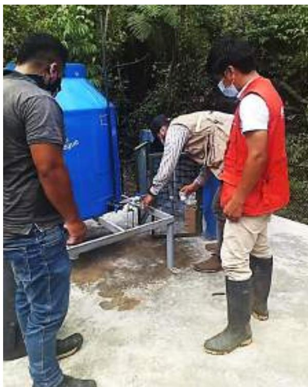
*Imagen V:* Capacitación al operador del agua en campo, en el mismo reservorio, del manejo de la cloración del agua potable. Fuente. Autor.
