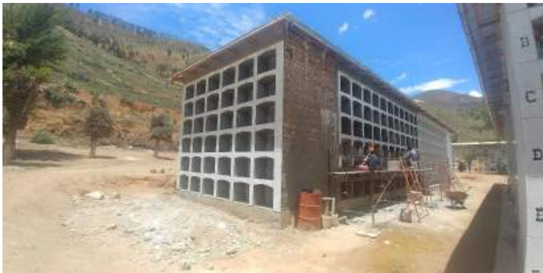
Figura 31: Actividad de Enchape en muro frontal con loseta cerámico.
