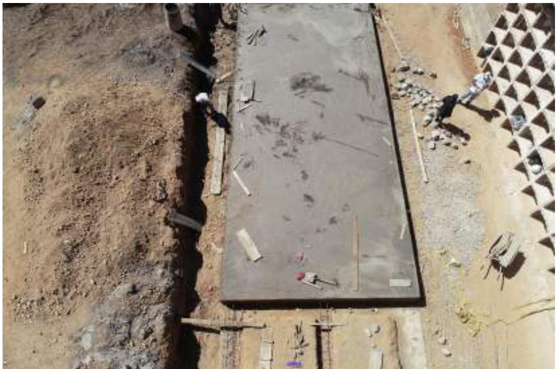
Figura 25: Vaciado con concreto - Falso Piso 4''
