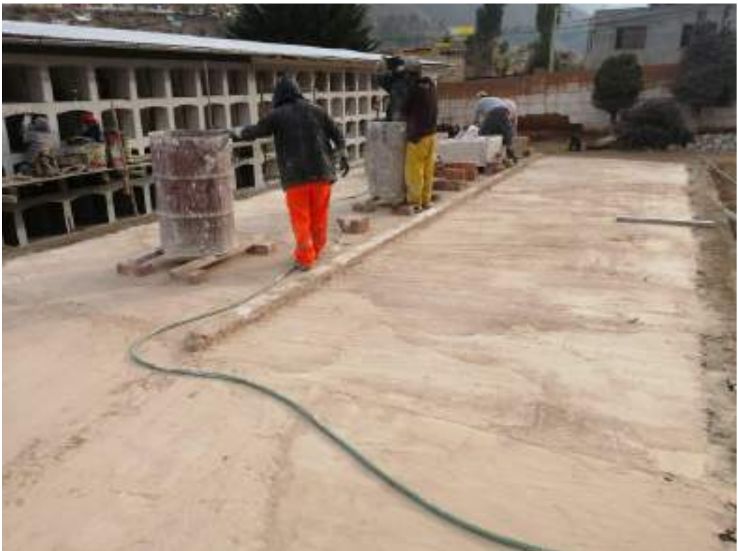
Figura 29: Vaciado de losa para nivelar encima de los techos de las bóvedas.
