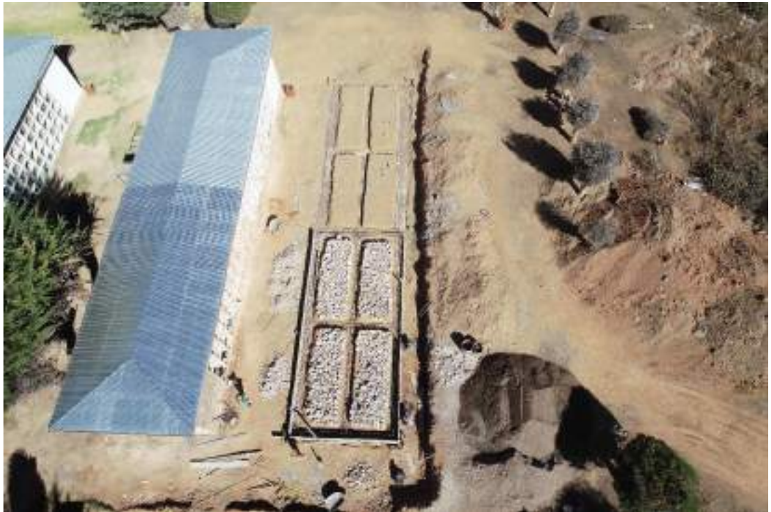
Figura 24: Empedrado de Falso Piso 4''
