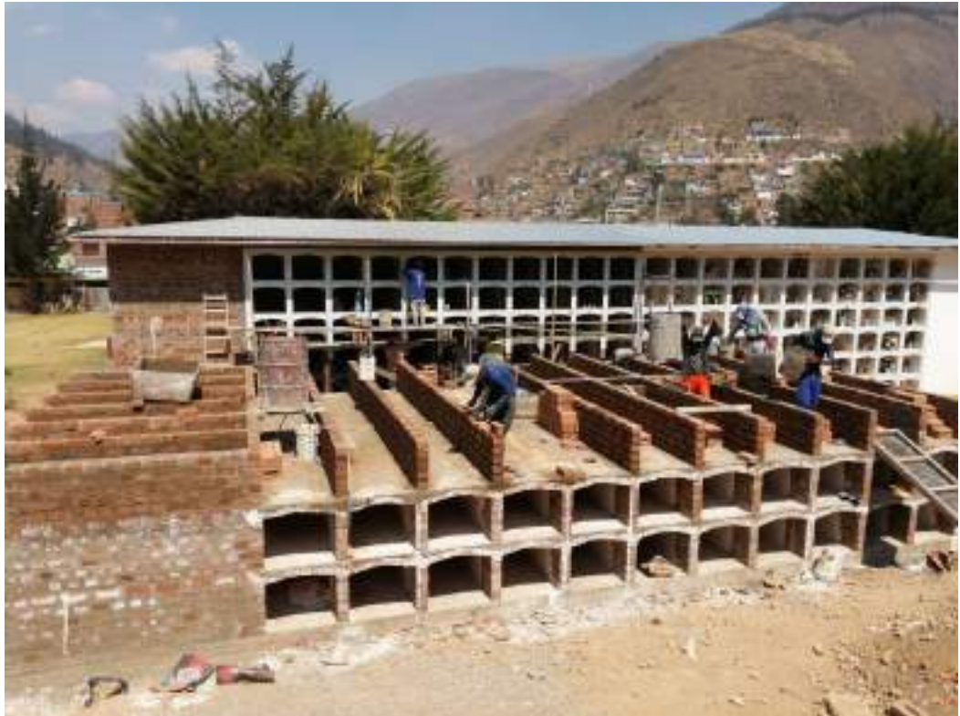
Figura 28: Armado de muro de ladrillo macizo con aparejo tradicional.
