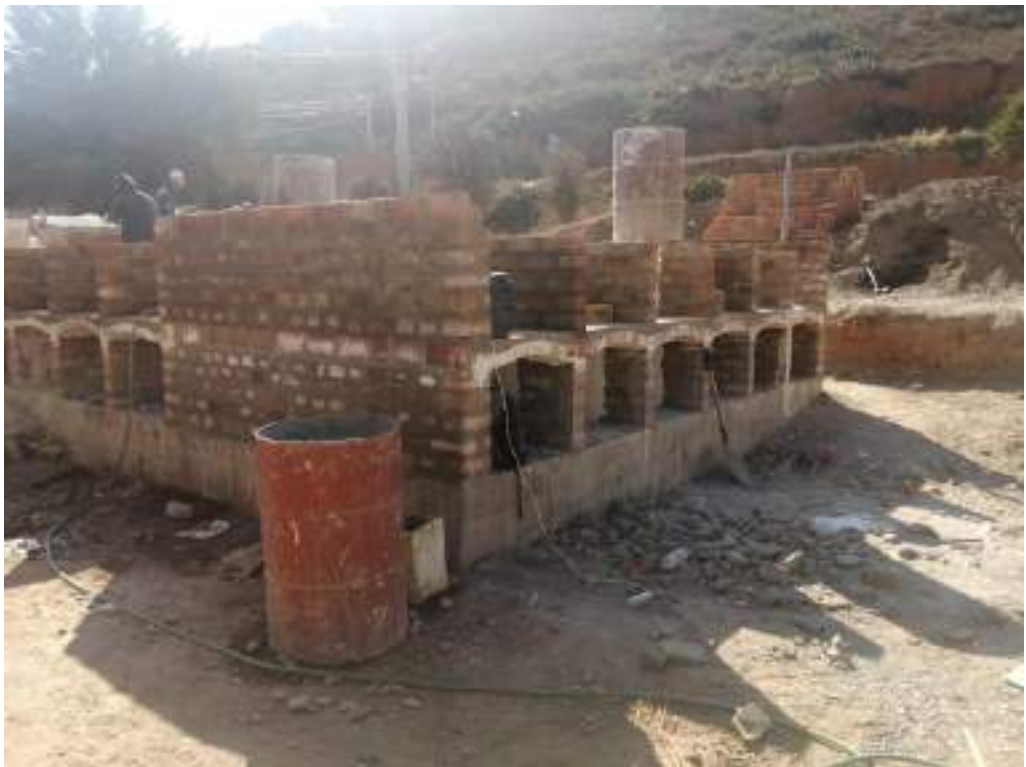
Figura 27: Armado de muro de ladrillo macizo con aparejo tradicional.
