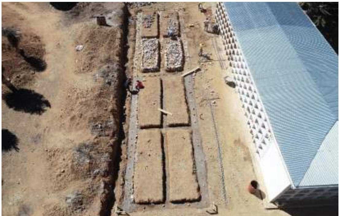
Figura 23: Preparación de Falso Piso 4''
