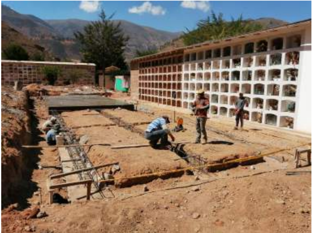
Figura 26: Armado de Vigas de Cimentación.
