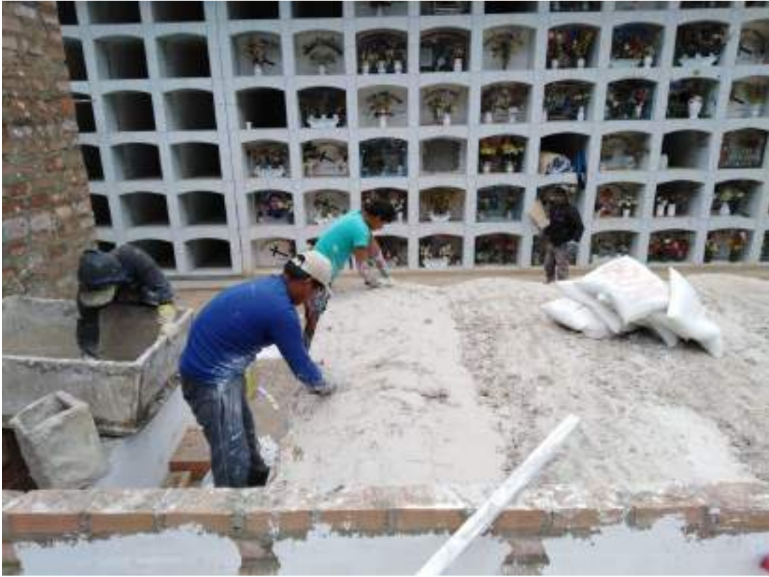
Figura 30: Armado de bóvedas.
