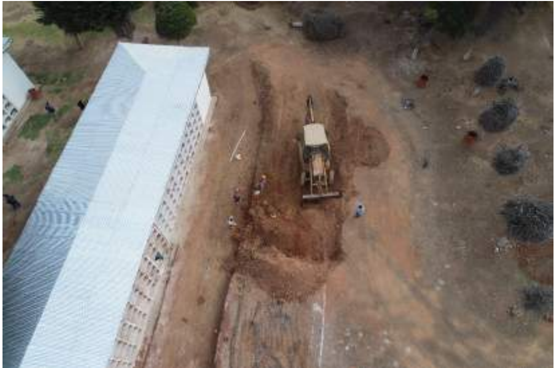
Figura 22: Actividad de excavación
