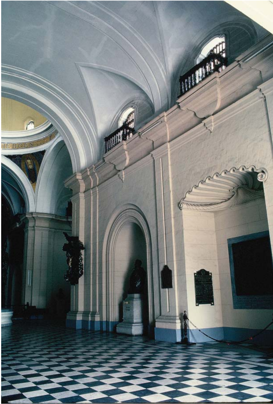
San Carlos. Muro lateral
