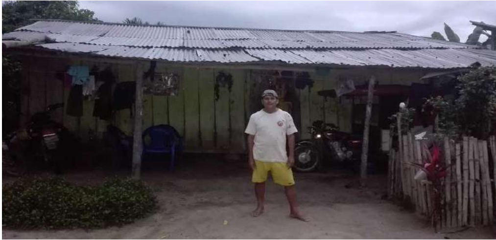
Imagen 01. Se muestra una vivienda con techo de calamina y tabiquería de madera.
