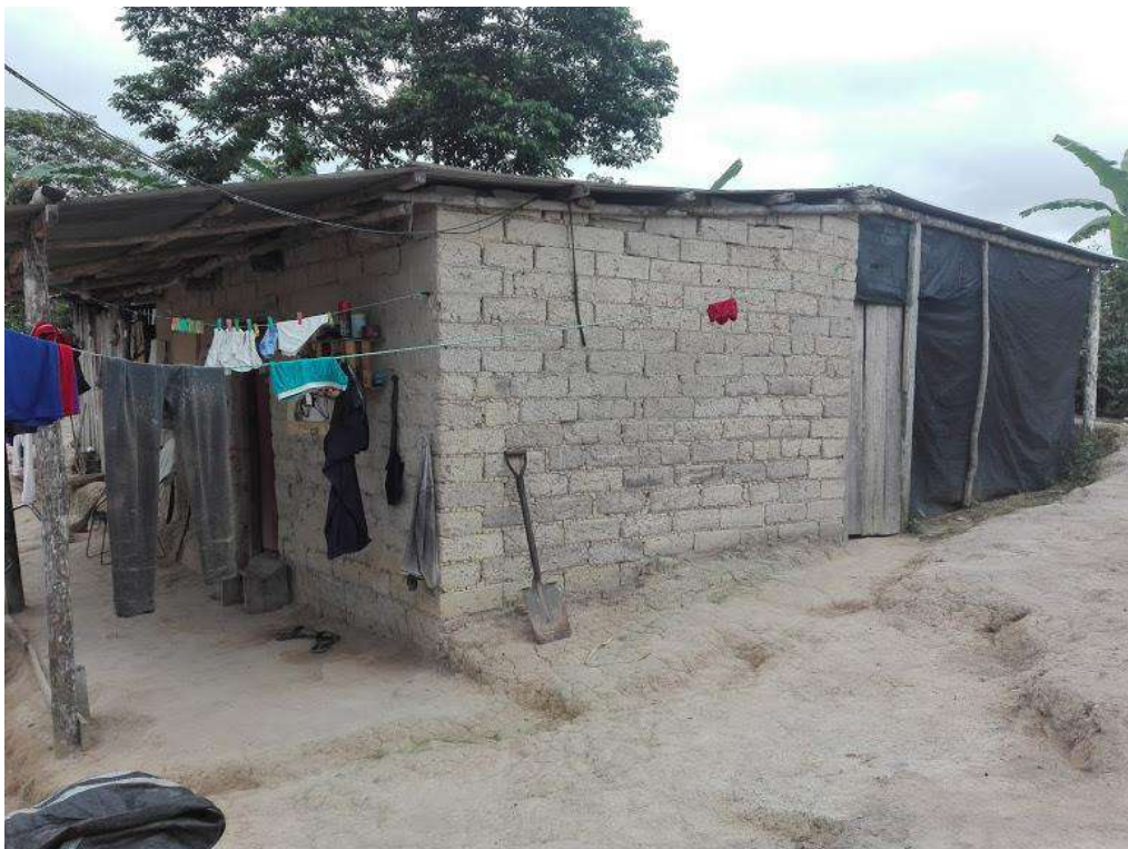
Imagen 04. Se muestra el modelo del ancho de las viviendas con techo de calamina y tabiquería de adobe.
