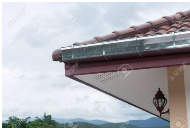
Figura 5. Canaletas de acero inoxidable
