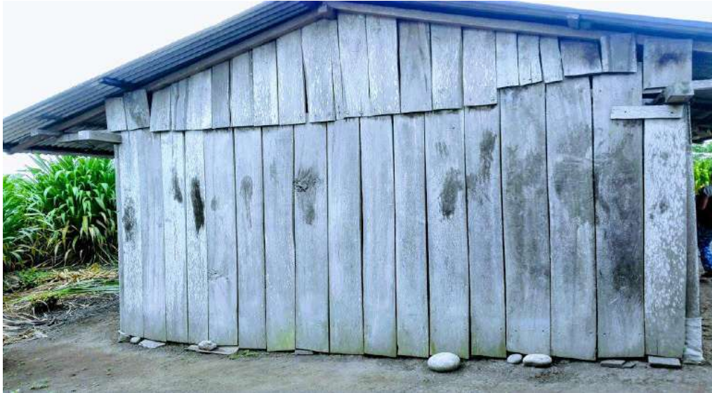
Imagen 03. Se muestra el modelo del ancho de las viviendas con techo de calamina y tabiquería de madera.
