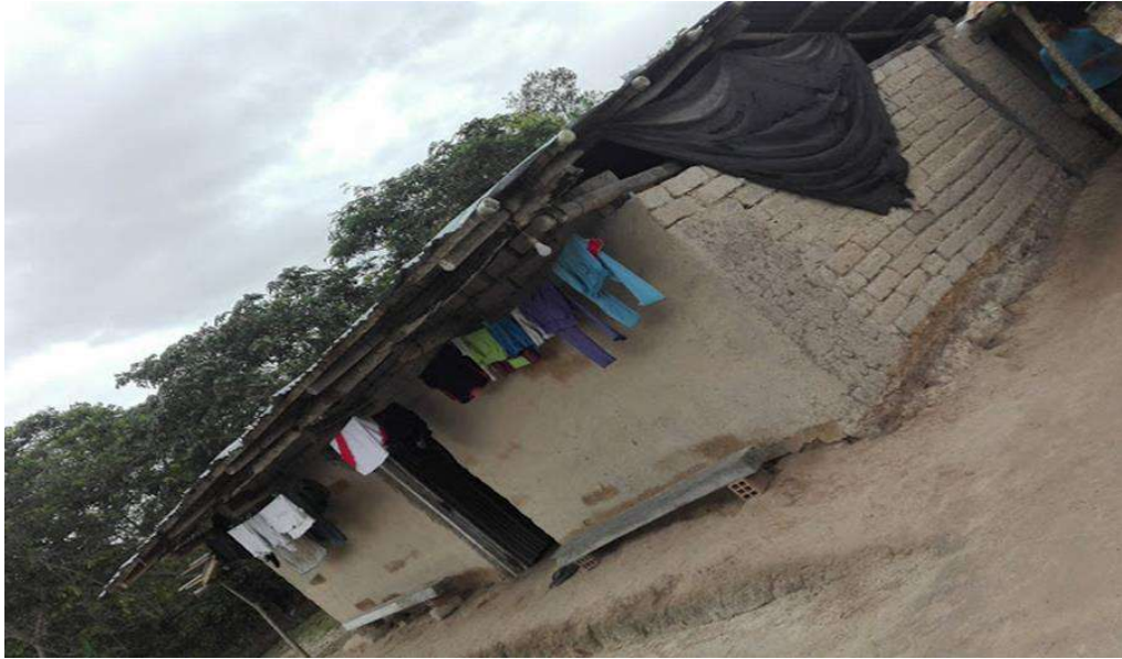
Imagen 05. Se muestra el modelo de las viviendas con techo de calamina y tabiquería de adobe. Las viviendas de los alrededores del centro poblado Santo Domingo no cuentan con servicios de agua potable y todas las encuestadas son con cobertura de calamina y tabiquería de madera y adobe.
