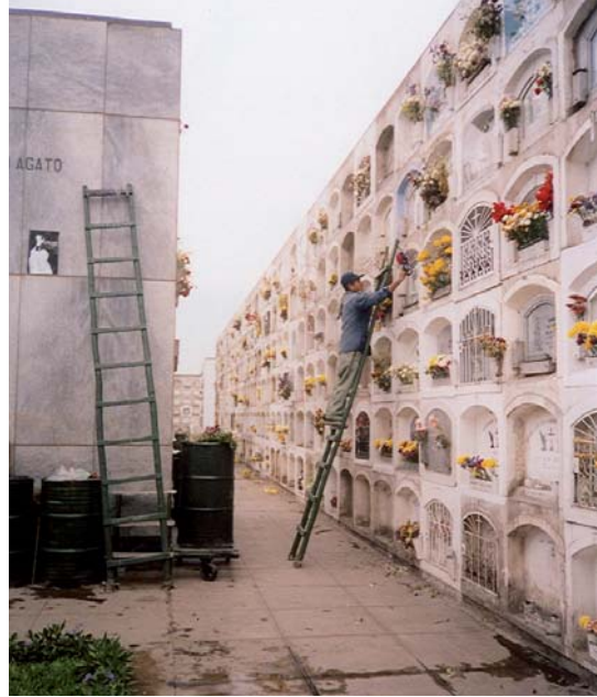
Vista general del Pabellón Santa Alma, 2007 (Archivo Santiago Túcunan, 2005)
