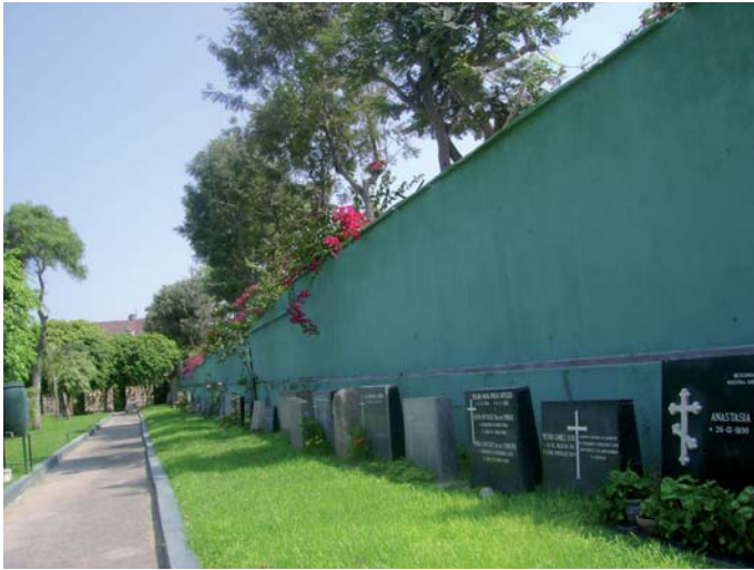
Avenida lateral del cementerio (Archivo Santiago Túcunan, 2005)
