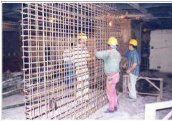
Ilustración 23. Reforzamiento con Muros Estructurales.
