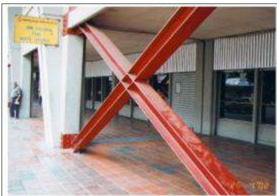
Ilustración 24. Reforzamiento con Arriostramientos Metálicos.
