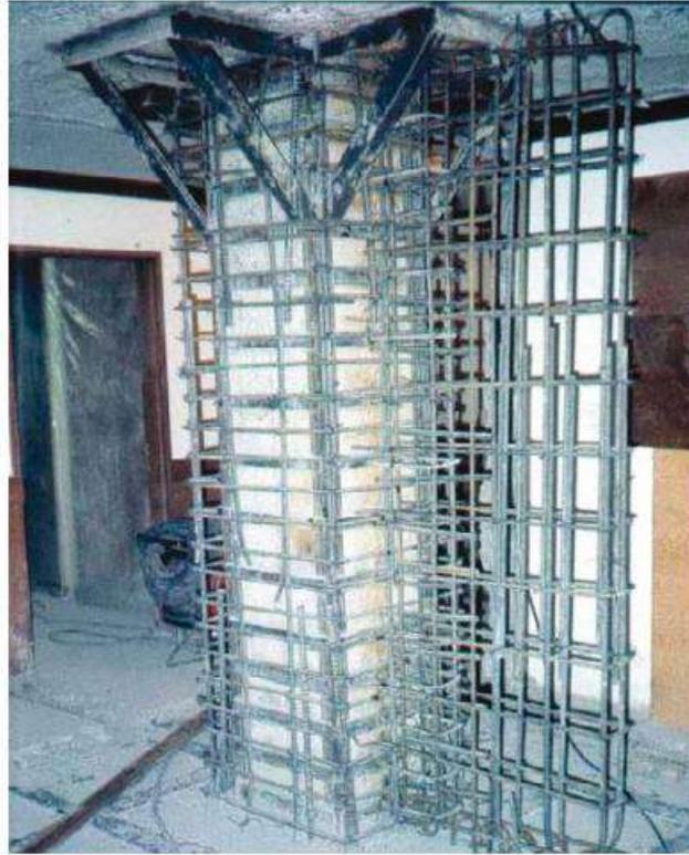
Ilustración 21 Encamisado y Adición de Muro Lateral en Concreto Reforzado de Columna en Edificio Comercial.
