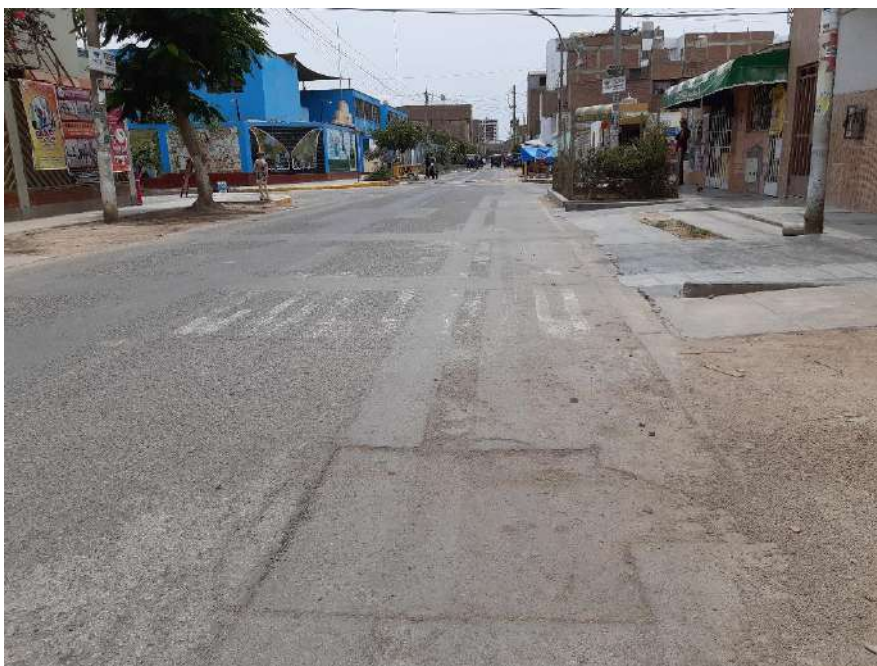
Figura 64. Pavimento con parches y desintegración Jr. San Hernán cuadra 1.
