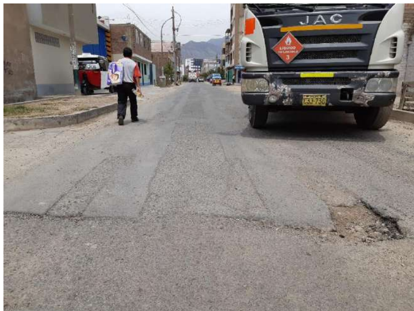
Figura 71. Pavimento deteriorado y hueco Jr. San Hernán cuadra 4.
