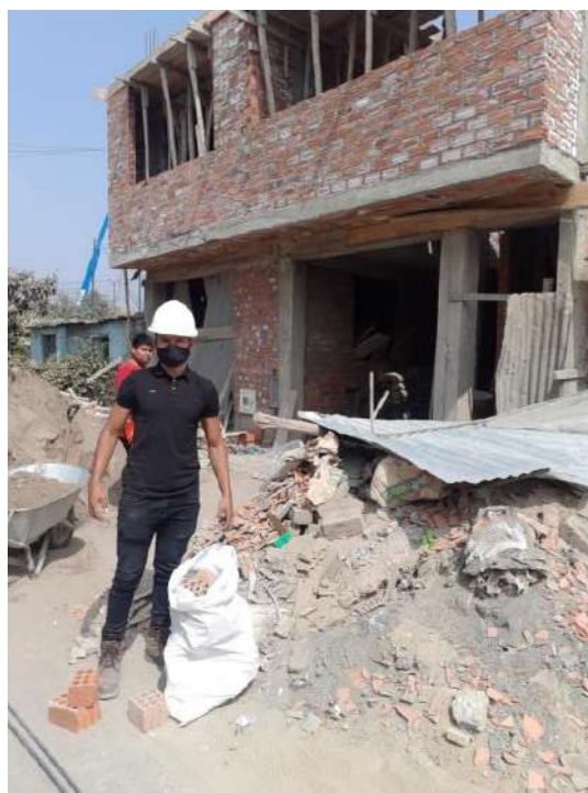
Figura 21. Obra N°1 recojo de material reciclable de la construcción.
