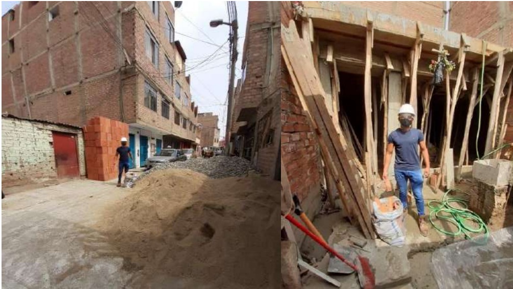
Figura 22. Obra N°2 recojo de material reciclable de la construcción.
