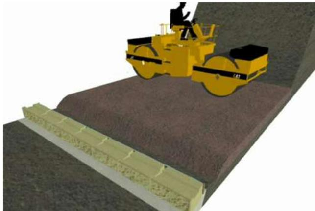
*Figura 25. Compactado de base y primera capa de tierra.*
