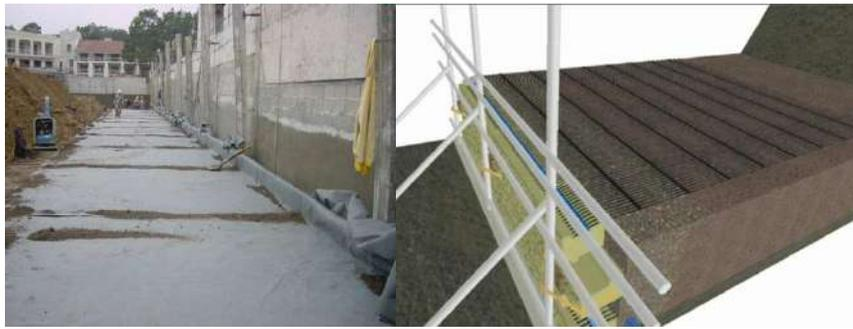
*Figura 26.* Colocado de geosintético, con traslape de 1.00 m.
