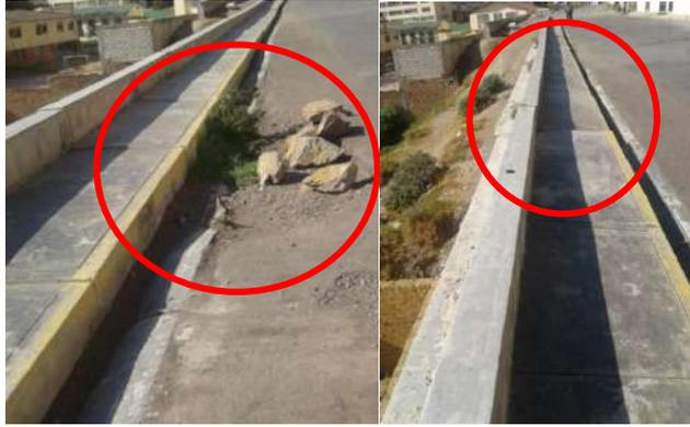
*Figura 2.* Hundimiento de muro de contención (concreto ciclópeo)
