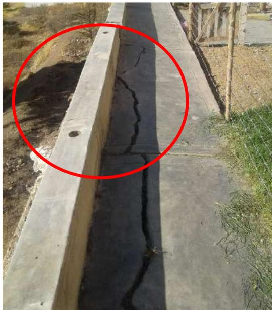
*Figura 1.* Deslizamiento de muro de contención (concreto ciclópeo)
