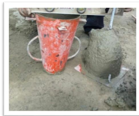
Figura 18. Asentamiento del concreto
