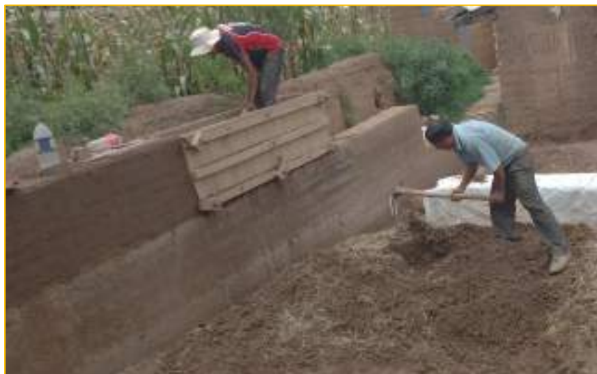
Figura 5. Construcción de muros de tapial.
