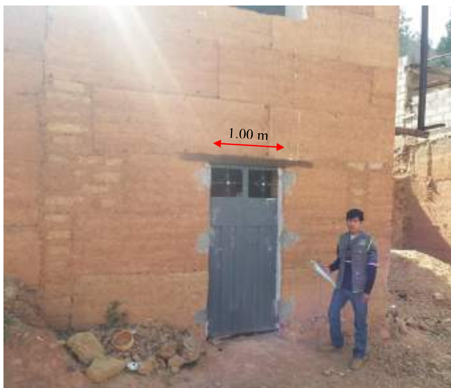
Figura 30. Vano de puerta.
