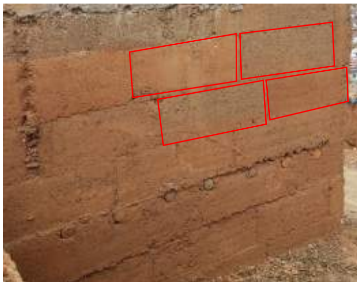
Figura 28. Asentado típico de muros de tapial.
