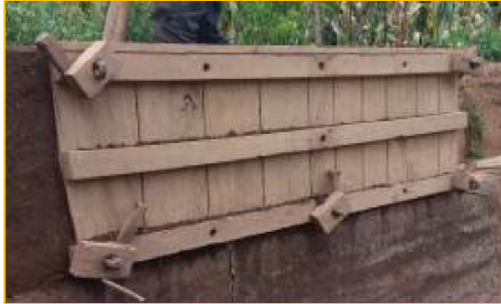
Figura 1. Encofrado para tapial.
