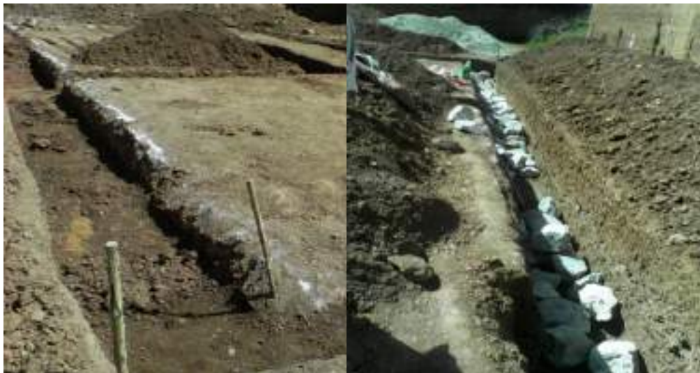
Figura 2. Proceso constructivo de la cimentación de viviendas de tapial.
