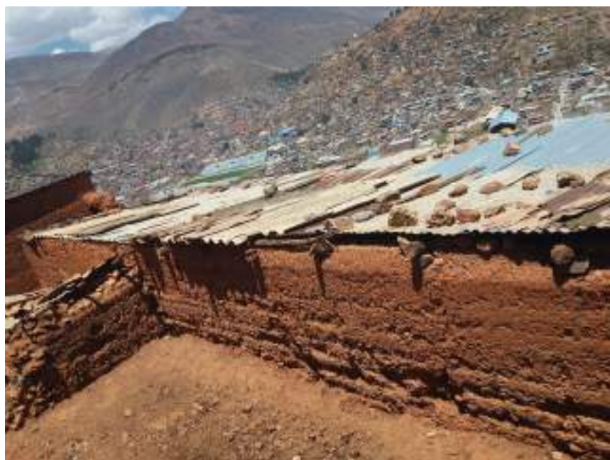
Figura 42. Edificación de tapial con techo de vigas de madera y calamina en mal estado.
