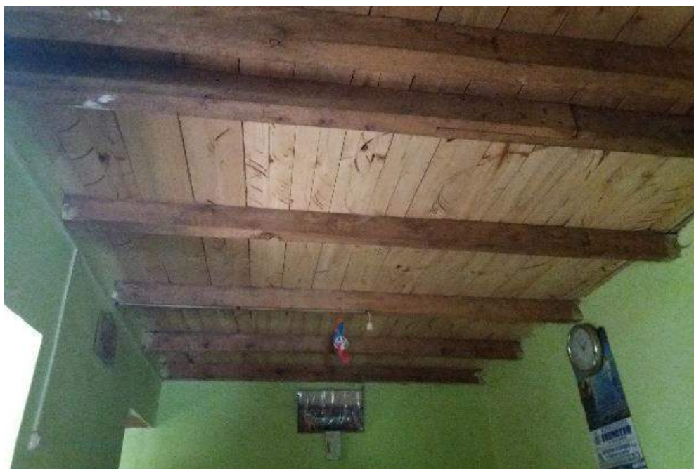
Figura 38. Edificación de tapial con entrepiso de viga y entablado.
