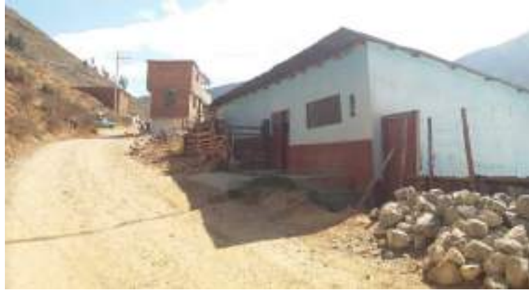
Figura 35. Buena calidad de sistema resistente, adecuado trabazón.
