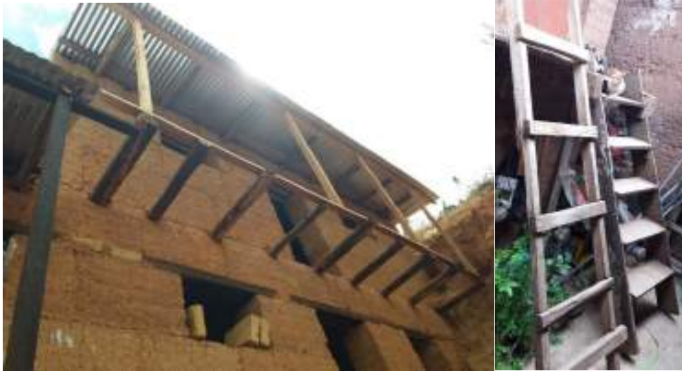
Figura 43. Edificación de tapial con balcón y gradas típicas.
