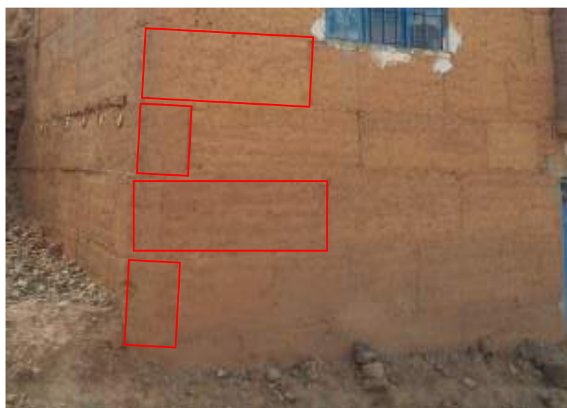
Figura 29. Asentado típico de muros de tapial en esquina.
