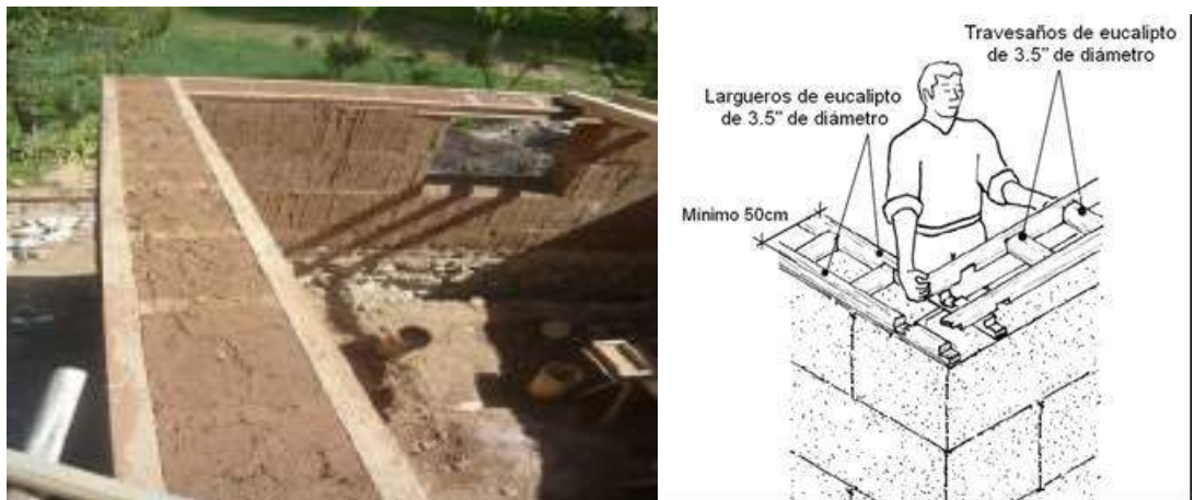
Figura 98. Colocación de vigas soleras en forma de escalerilla sobre muro.
