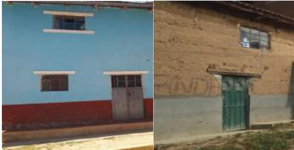
Figura 26. Zócalos y veredas en viviendas de tapial.
