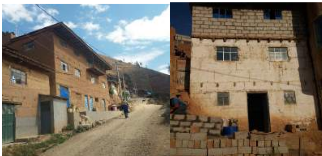
Figura 40. Edificación de tapial de tres niveles.
