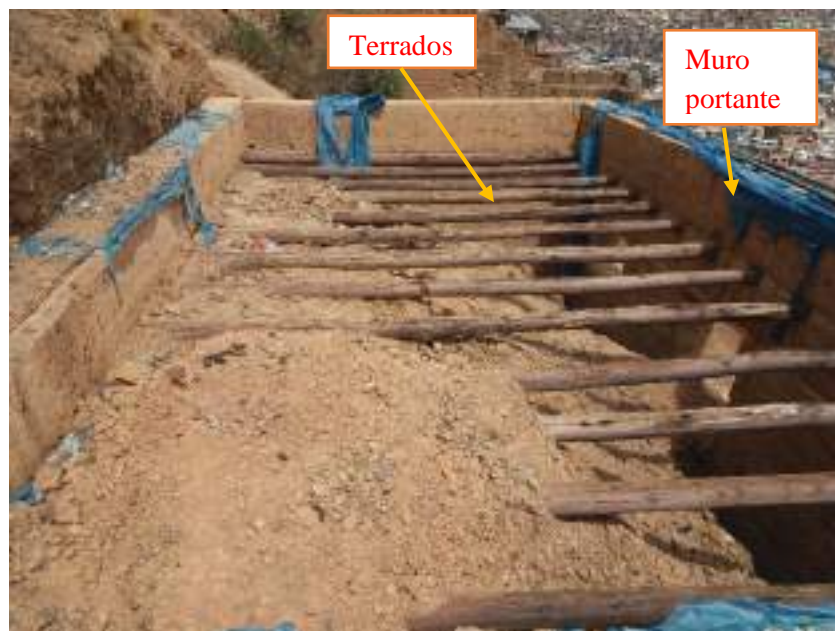
Figura 31. Vigas de entrepiso, terrados.
