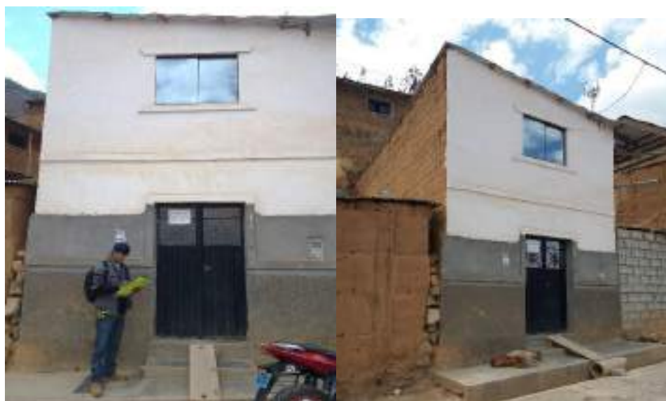
Figura 39. Edificación de tapial con una adecuada distribución de masas.
