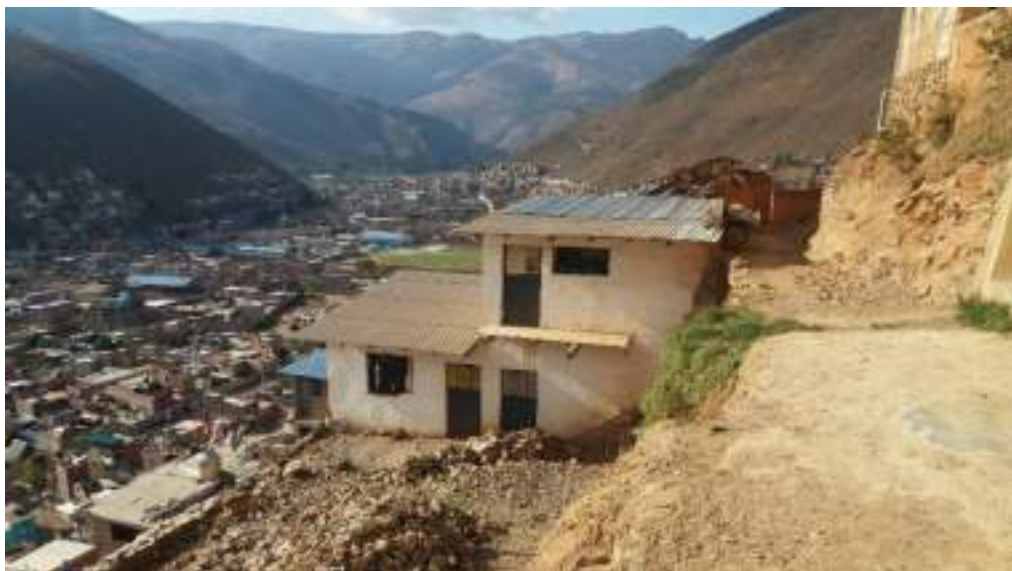
Figura 19. Vivienda en pendiente y soportando empujes del terreno.
