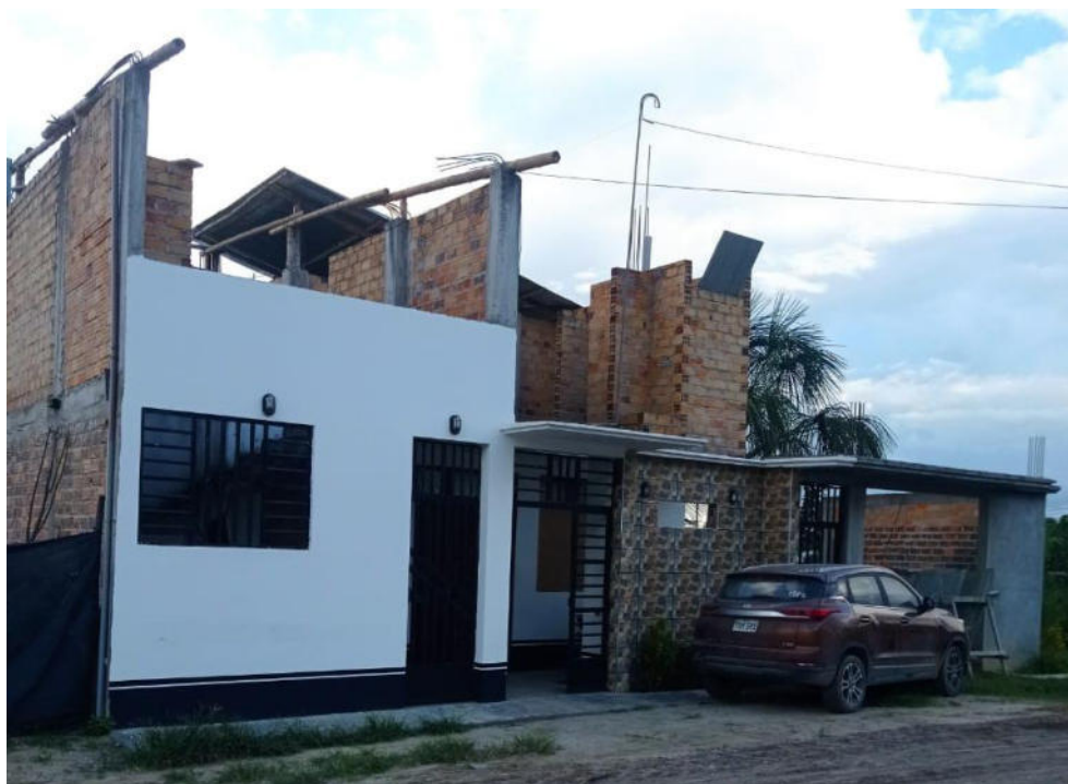
Acabado de fachada
