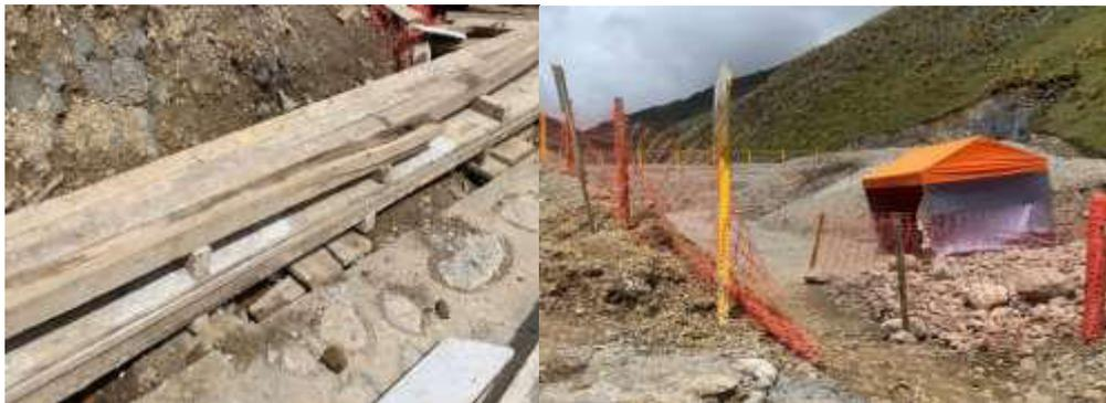
Se implementa tacos tipo soporte, para el correcto apilamiento de las maderas de encofrado y evitar aprisionamiento de dedos y manos, también se realizó un orden y limpieza, y se delimita el área con postes y mallas de señalización en el canal de coronación durante la colocación de tapas de concreto armado.
