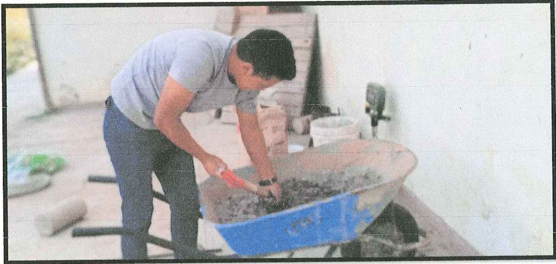
FOTO 02 Mezclado de los materiales (agregado fino, agregado grueso, cemento y agua)
