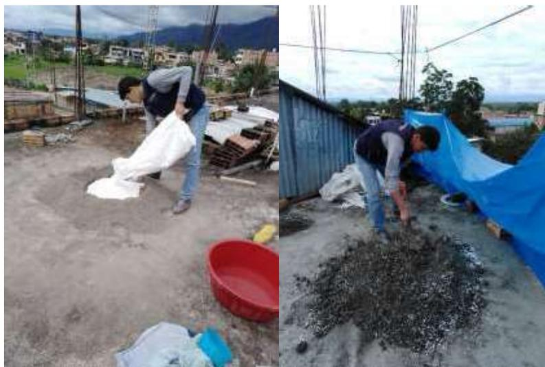
Figura 6. *Mezclado manual*. Fuente: Elaboración propia (2021).
