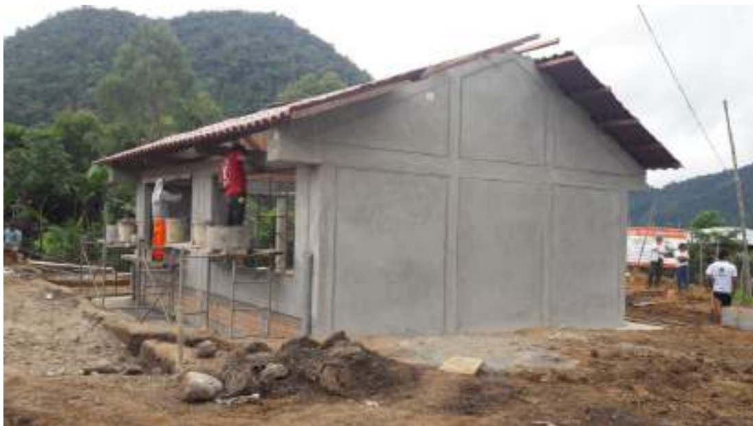
ANEXO 10: Tarrajeo de muros.
