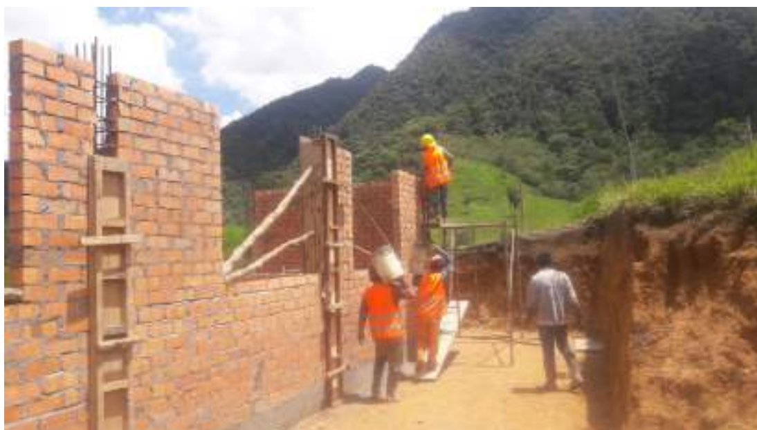
ANEXO 8: Imagen que muestra encofrado de columnas de concreto.
