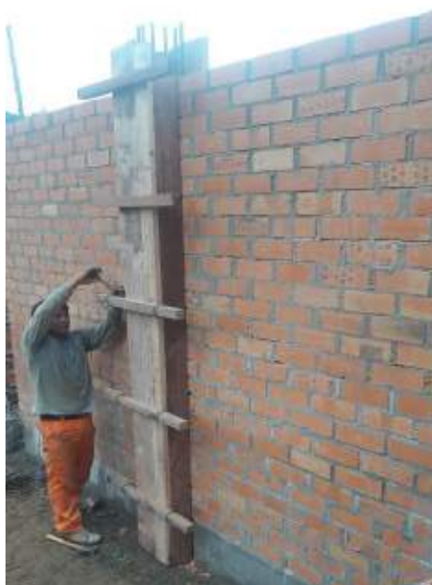
ANEXO 8: Imagen que muestra encofrado de columnas de concreto.
