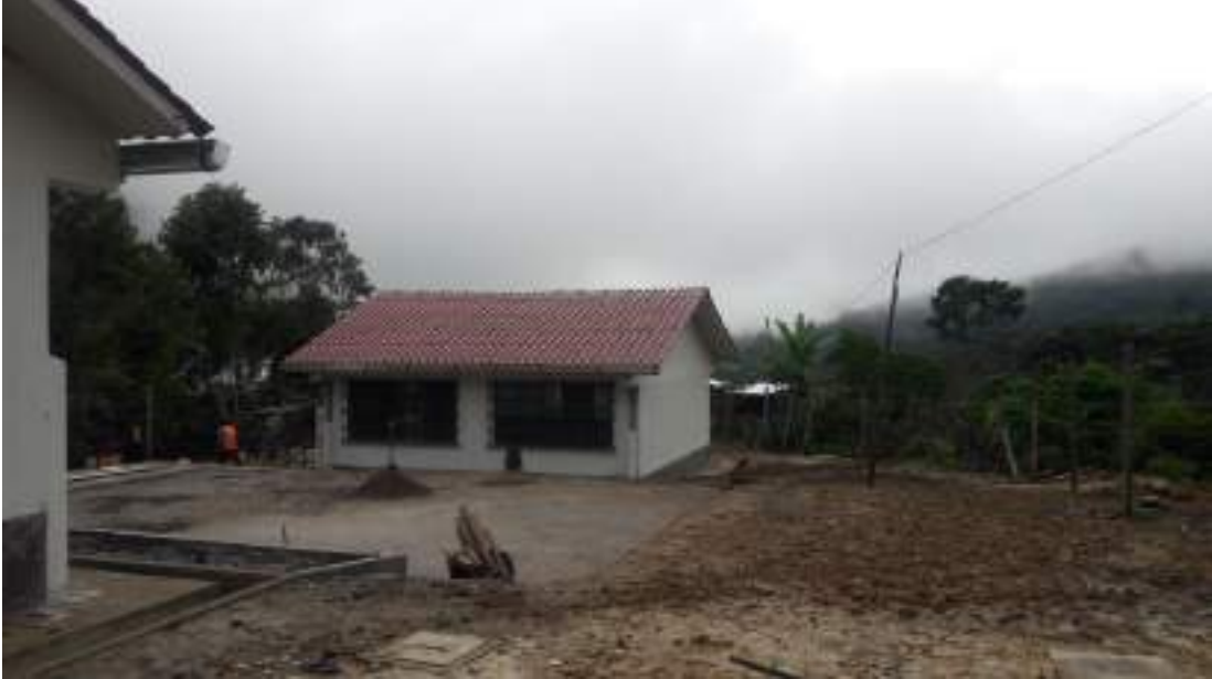
ANEXO 11: Ejecución de acabados en el proyecto.
