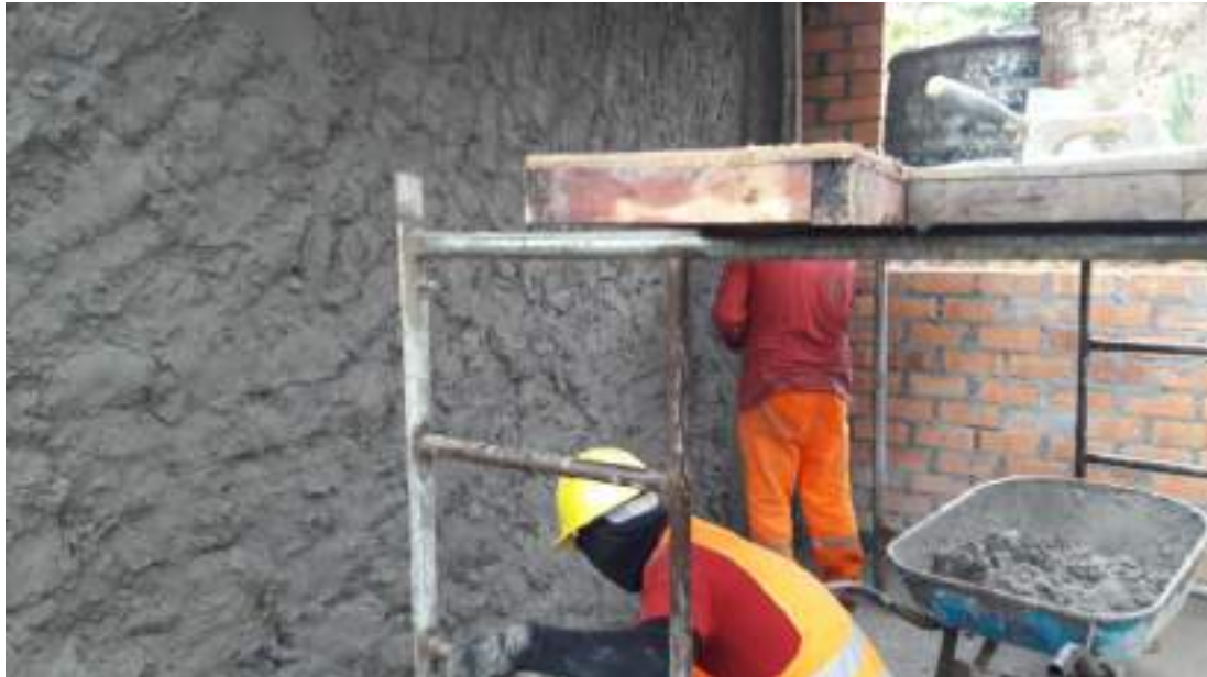
ANEXO 9: Pañeteo en muro para tarrajeo
