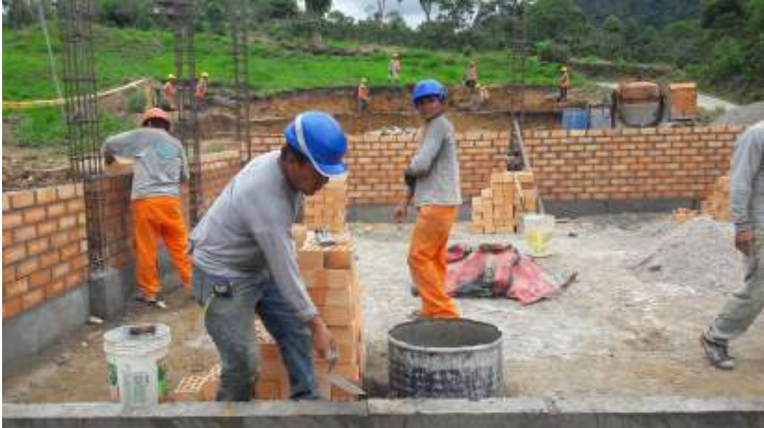
ANEXO 5: Asentado de muro de ladrillo en aparejo de soga.
