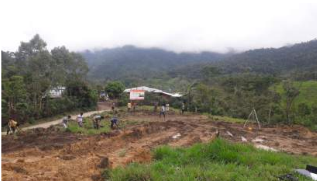
ANEXO 2: Personal laborando en excavación manual.
