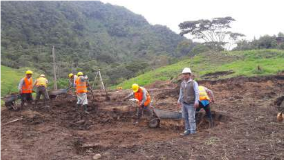
ANEXO 3: Personal empelando herramientas manuales para excavación de terreno.
