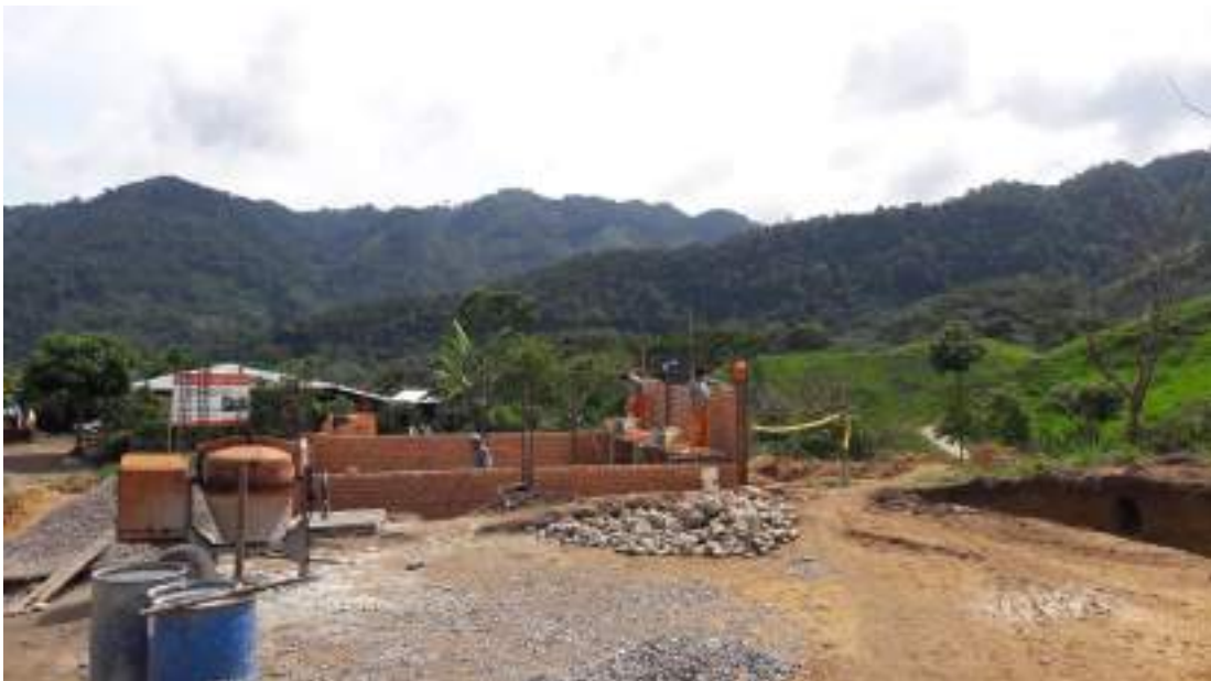
ANEXO 6: Asentado de muros de ladrillo.
