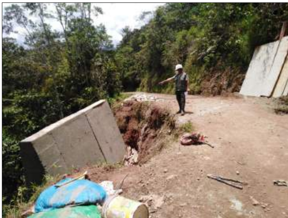
Figura 21: Desencofrado del muro de contención (fuente: propia)
