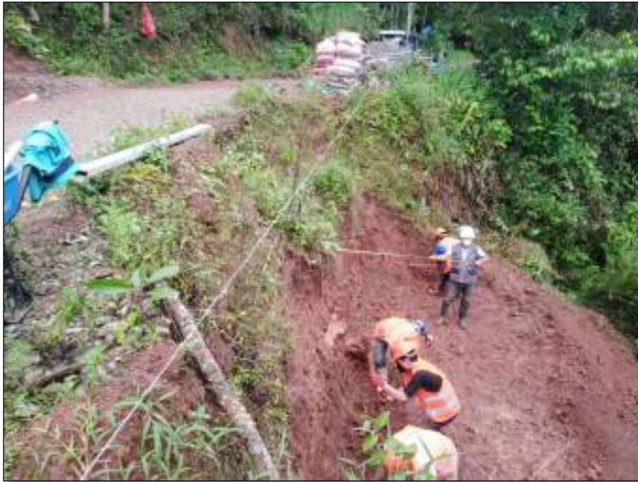
Figura 20: Excavación para la cimentación (fuente: propia)
