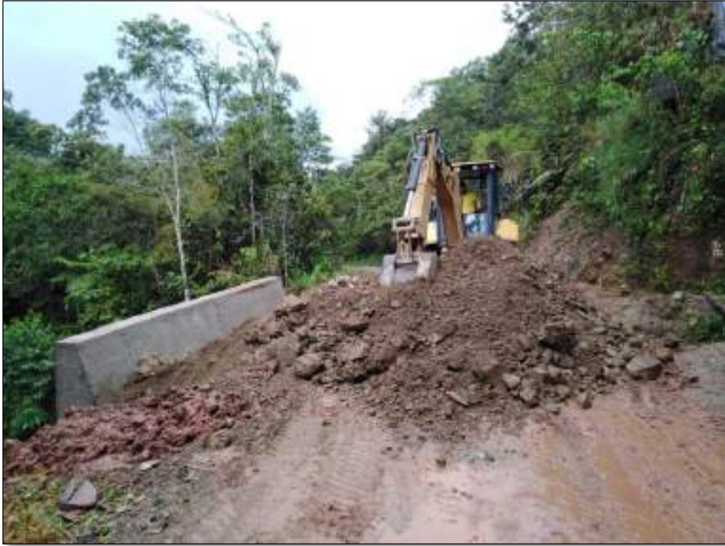
Figura 22: Relleno con material de préstamo (fuente: propia)
