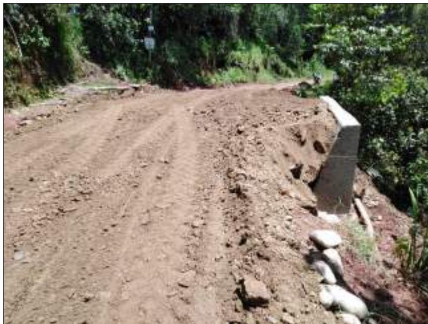
Figura 23: Muro terminado (fuente: propia)
