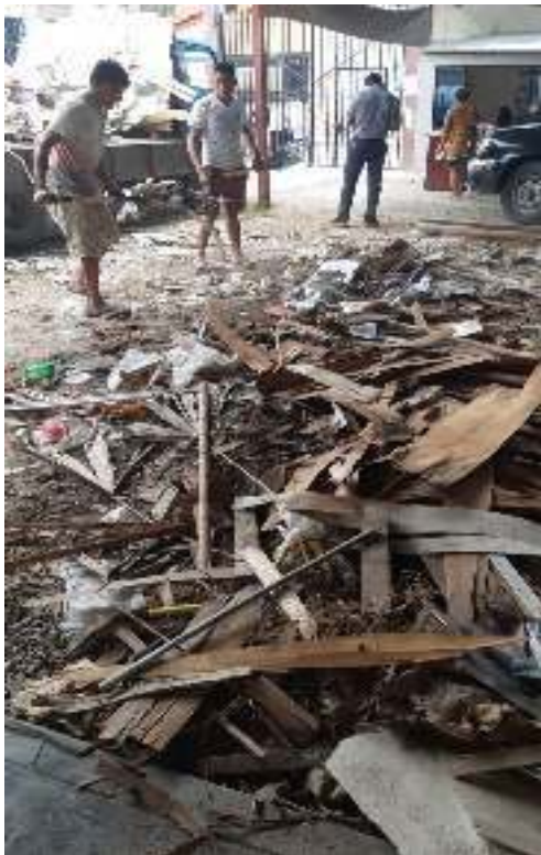
Fotografía 13. Falta de señalizaciones tanto para usuarios internos como externos.
