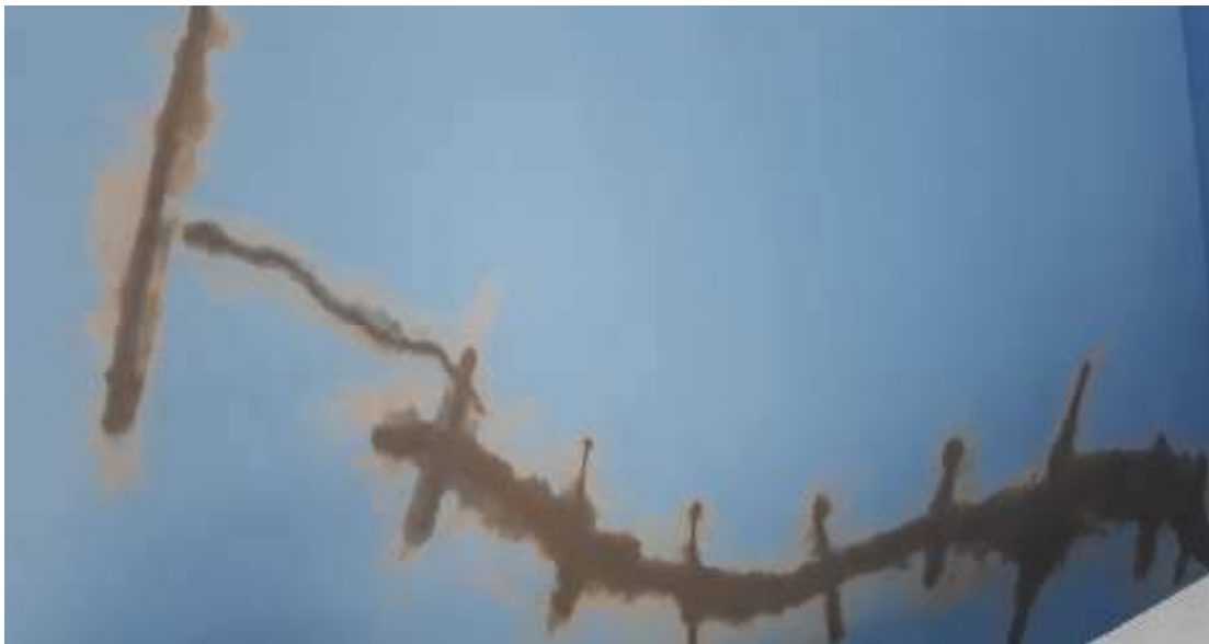
Fotografía 4. Resanado de muro
