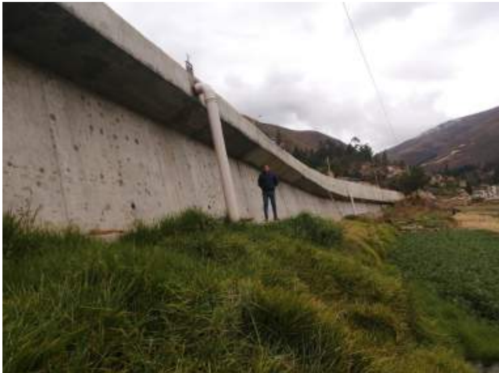
Figura 54: Muro de contención en voladizo H=4.80m
