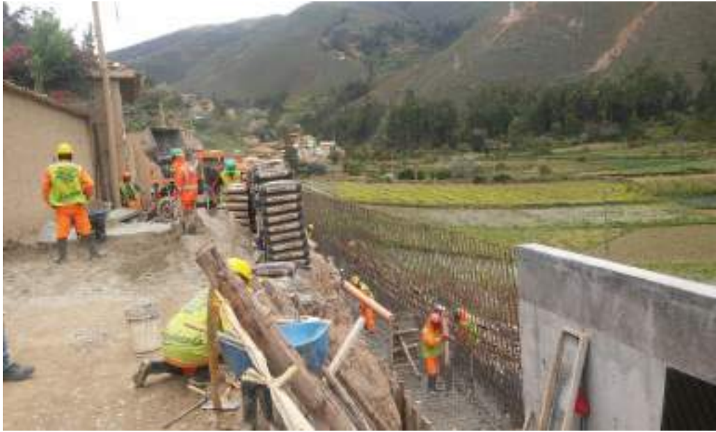
Figura 45. Vaciado de concreto para zapata f'c=210\text{kg/cm}^2 .
