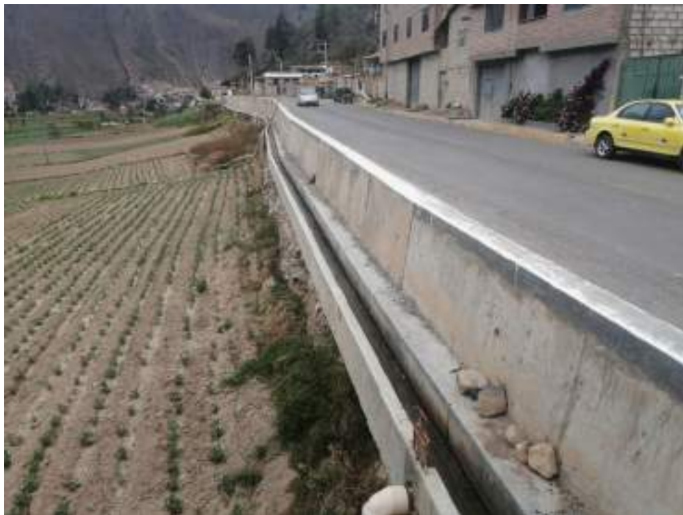
Figura 52: Muro de contención en voladizo H=3.00m
