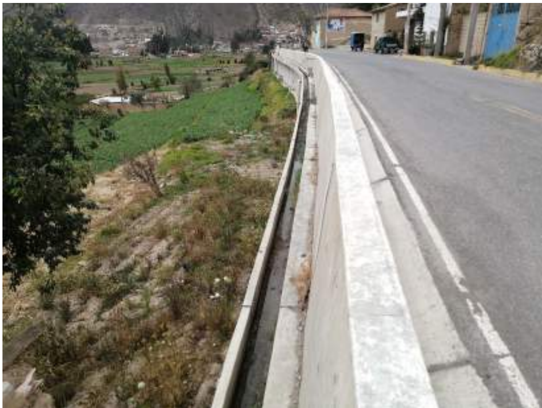
Figura 56: Vista panorámica muro de contención y carpeta asfáltica en la carretera
