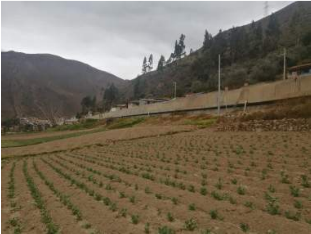
Figura 53: Vista panorámica muro de contención en voladizo
