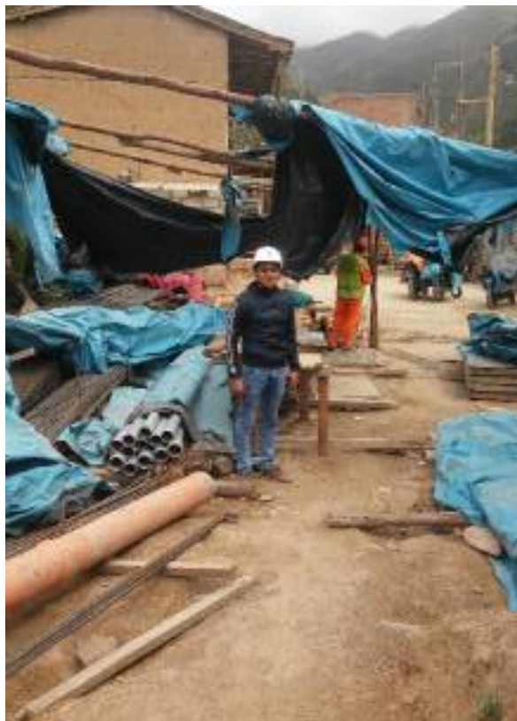
Figura 50. Habilitación de acero para muro de contención y canal de riego.
