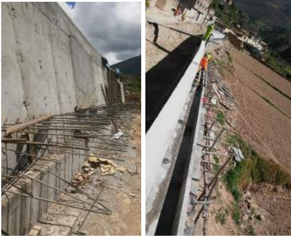
Figura 48. Armadura de acero para canal de riego.
