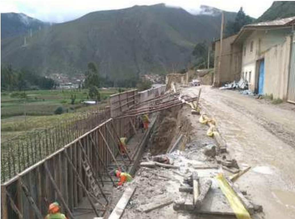
Figura 46. Encofrado para muro de contención en voladizo H=3.00 .
