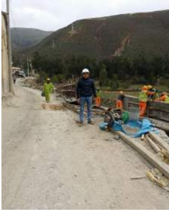
Figura 49. Desencofrado de muro de contención H=4.80m.
