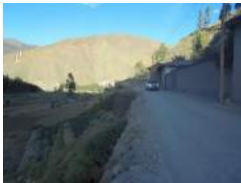
Figura 14. Vista del tramo 0+500 al 2+000
