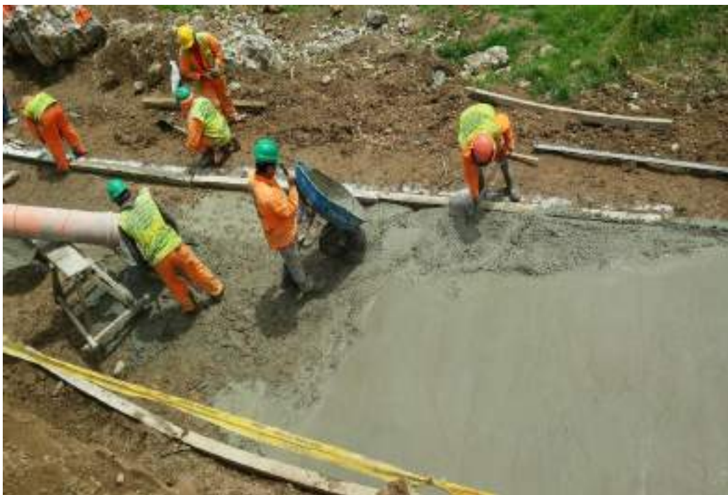
Figura 44. Vaciado de concreto para solado f'c=100\text{kg/cm}^2 .
