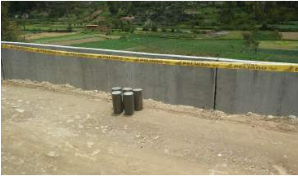
Figura 47. Elaboración de probetas de concreto.
