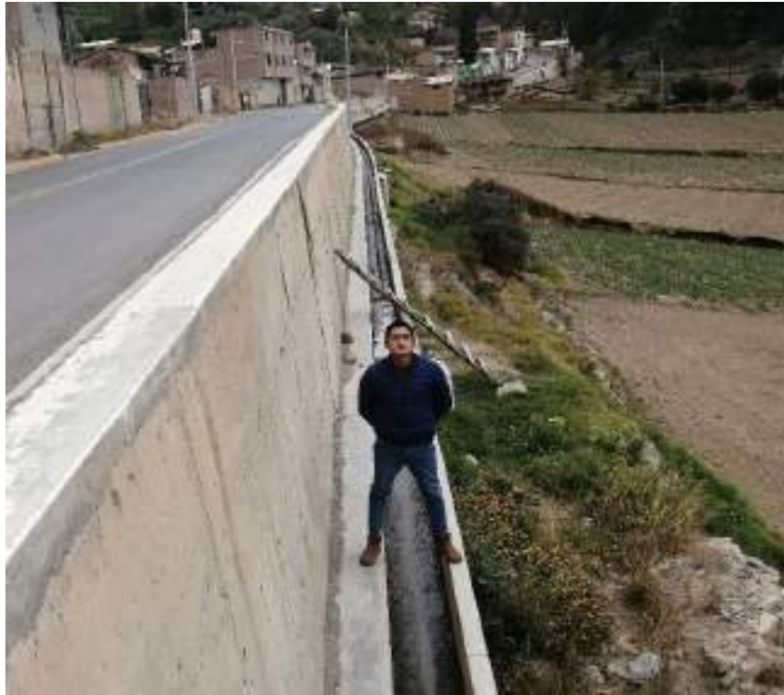
Figura 55: Muro de contención en voladizo y canal de riego km0+750
