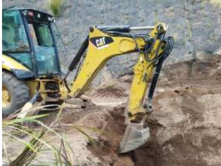
Figura 2: Excavación Mecánica Fuente: ROFE Constructora
