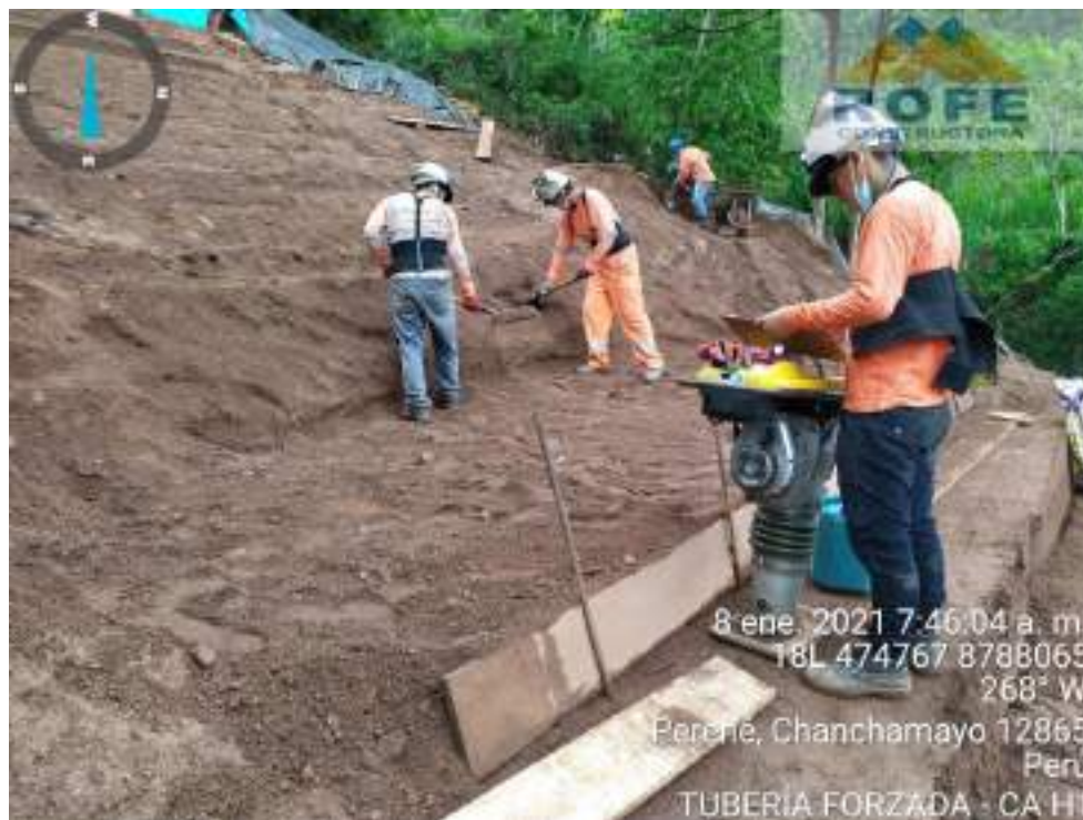
Figura 33: Mantenimiento de equipos mediano – in situ Fuente: ROFE construcciones E.I.R.L.
