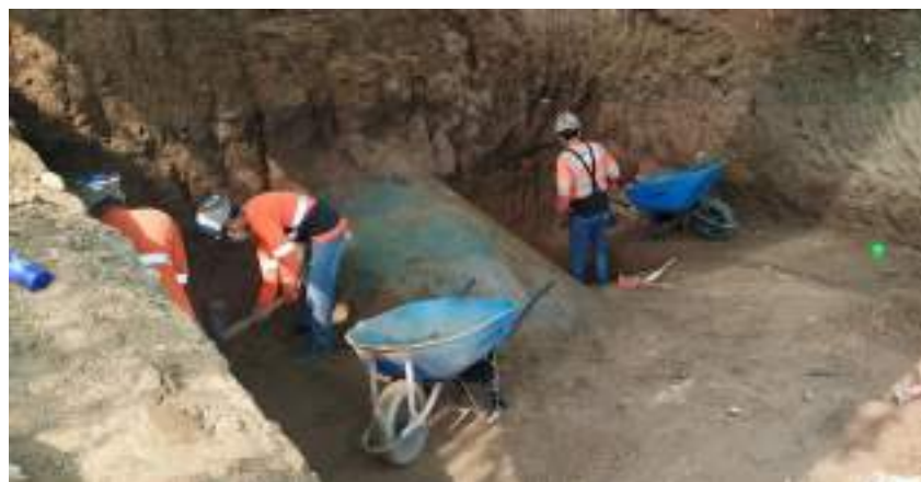
Figura 1: Excavación manual Fuente: ROFE Constructora
