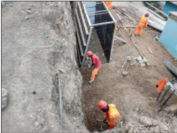
*Figura 32.* Trabajos de encofrado de muro.
