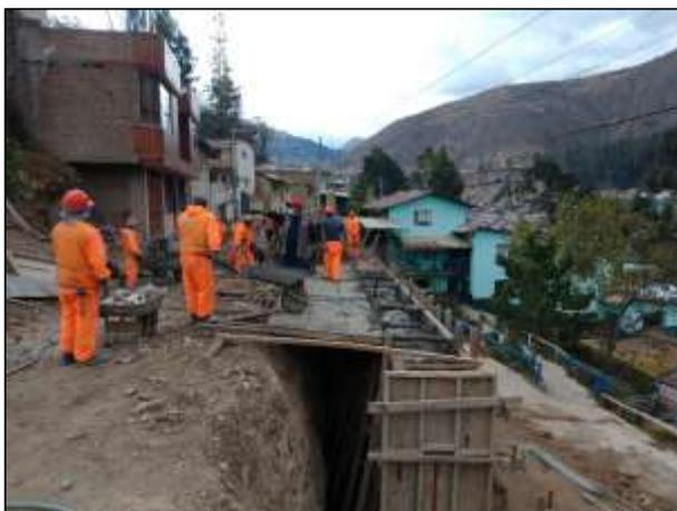
*Figura 33.* Se observa el vaciado de concreto en muro de contención.
