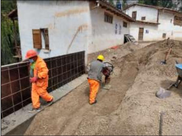
*Figura 34.* Relleno de zanjas con material de préstamo.
