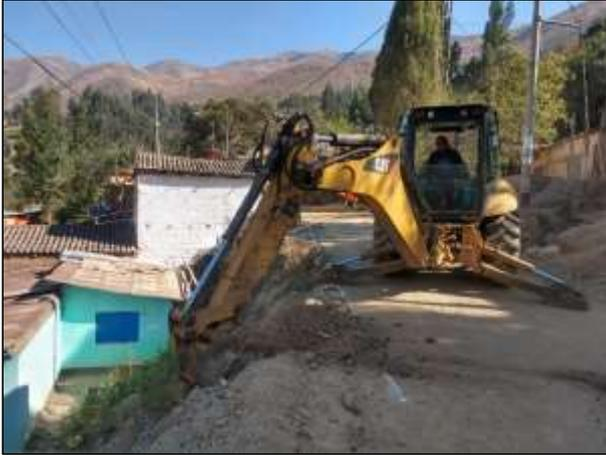
*Figura 30.* Se observa la excavación de zanjas con la retroexcavadora.
