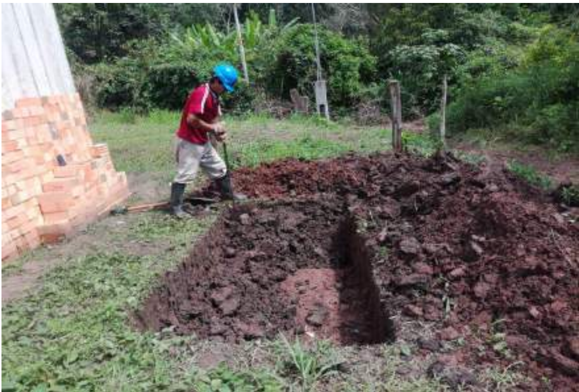
Figura 11: Excavación en terreno normal.
