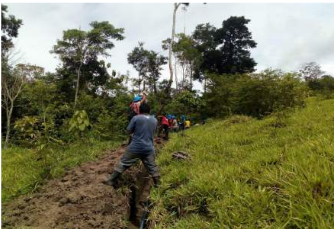
Figura 17: Primer relleno de la zanja, para el tapado de la tubería.
