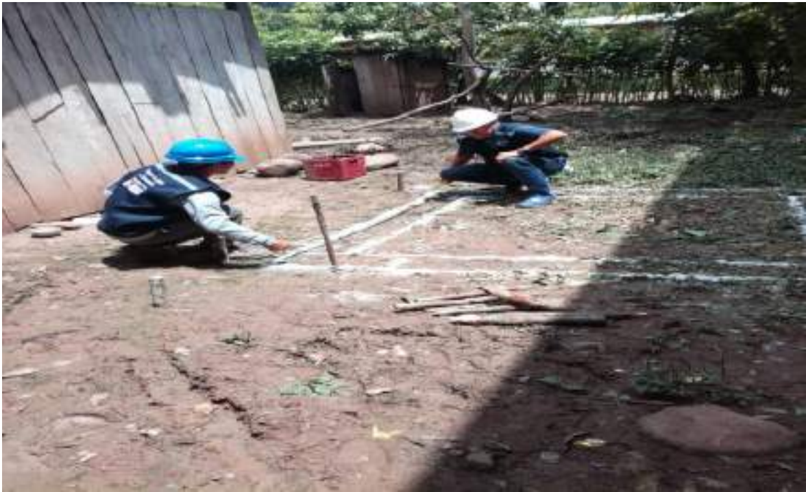
Figura 10: Trazo y replanteo, correspondiente a un módulo.
