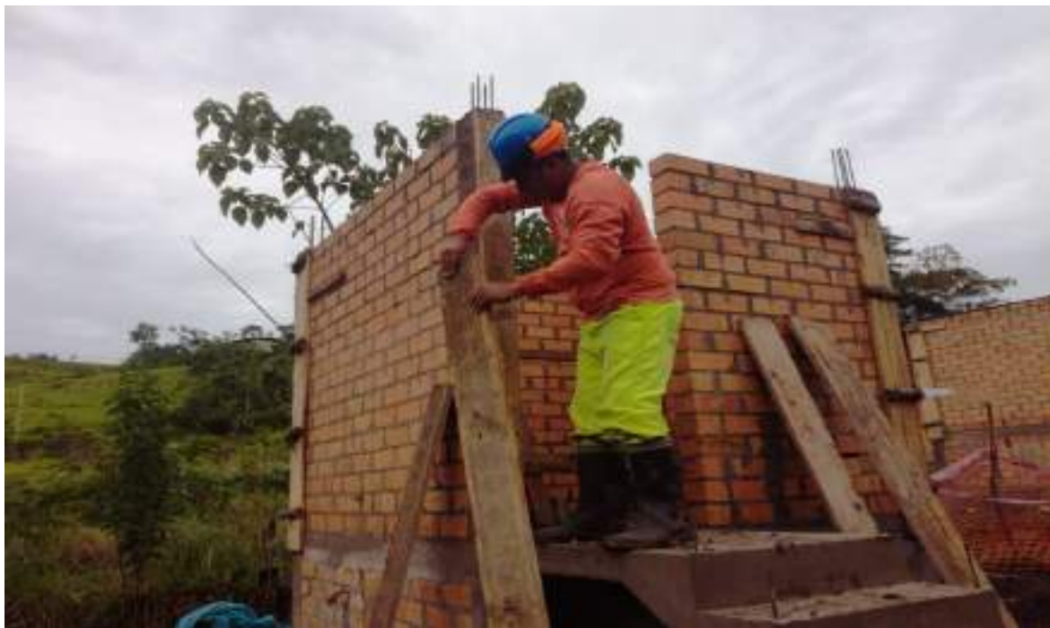
Figura 18: Encofrado de las columnas en un módulo completo.
