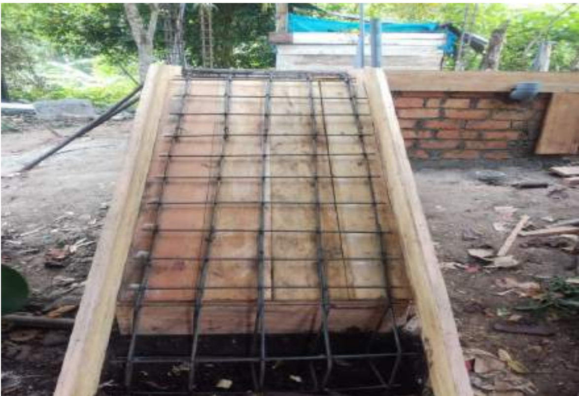
Figura 13: Encofrado y desencofrado en la escalera de un módulo.
