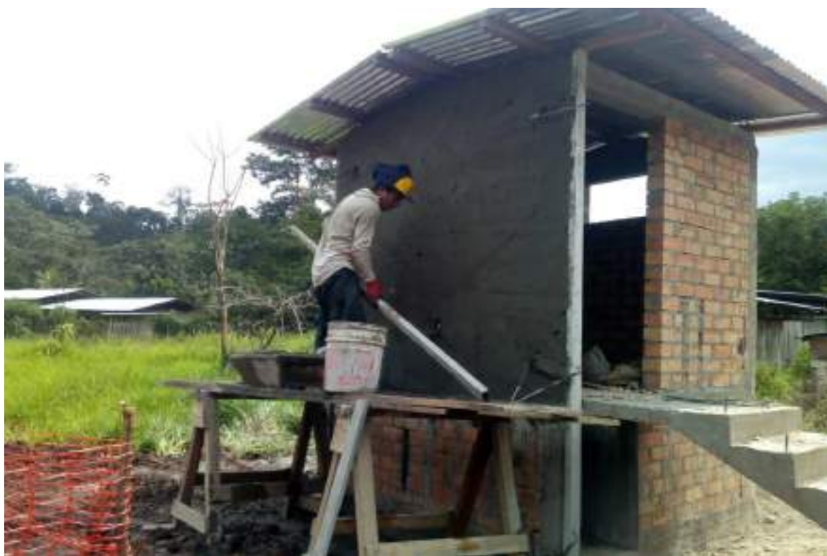
Figura 15: Tarrajeo en muros exteriores, en un módulo del proyecto.
