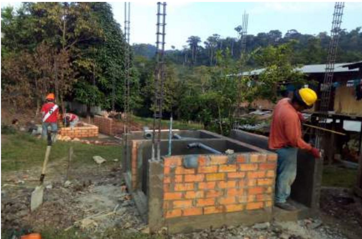
Figura 14: Muro de ladrillo, KK de Arcilla, asentado tipo sogá.
